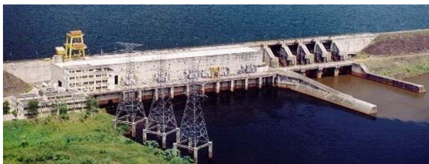
Figura 5.1- Usina hidrelétrica de Balbina.
