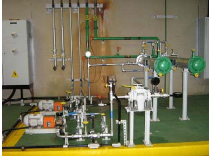
Figura A.6- Sistema de lubrificação e resfriamento do mancal guia do gerador.
