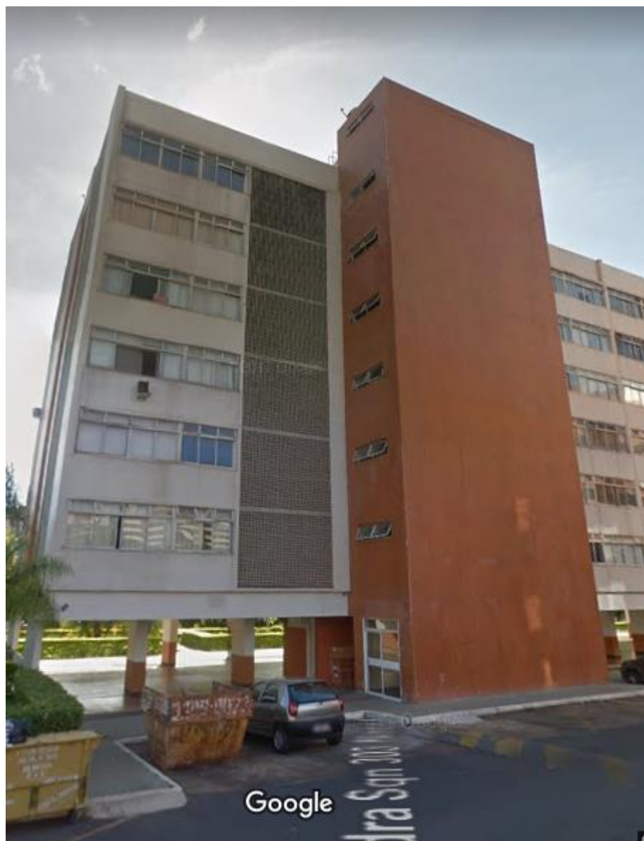
Figura 51: Fachada Oeste 4 Edifício Edifícios D (MAPS, 2019).
