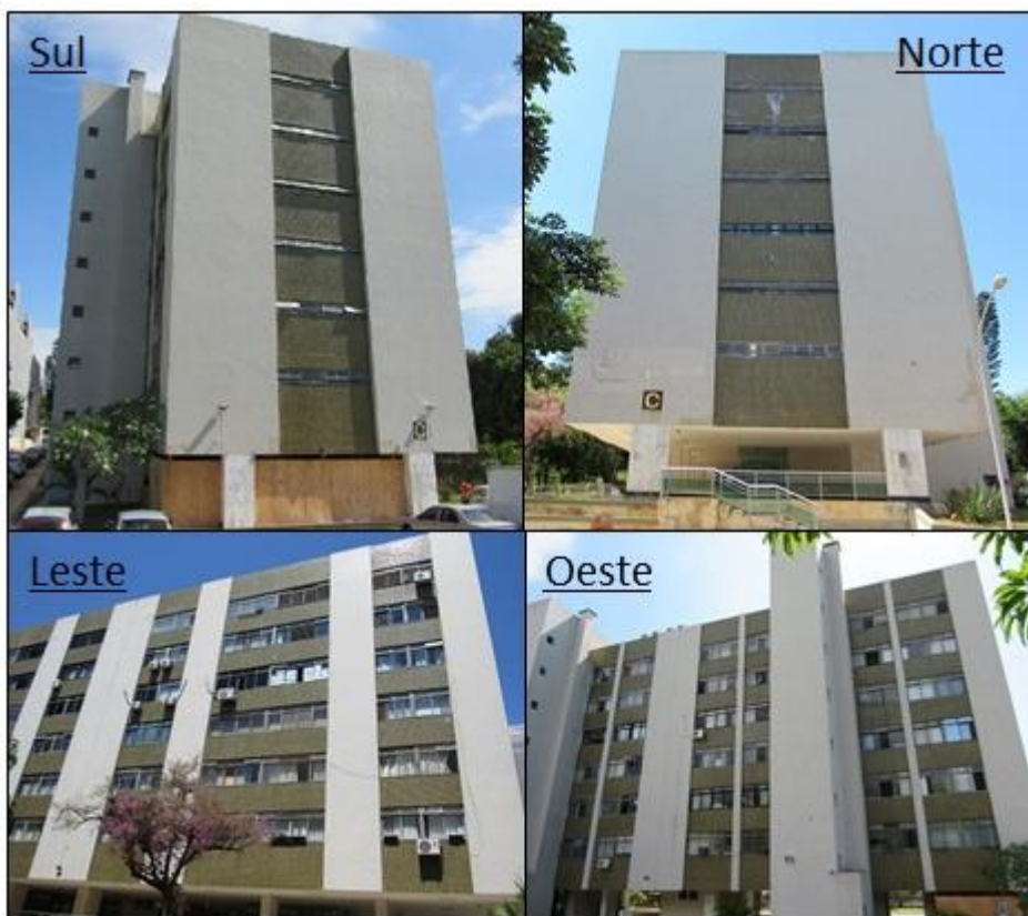
Figura 34: Fachadas Edifício A.
