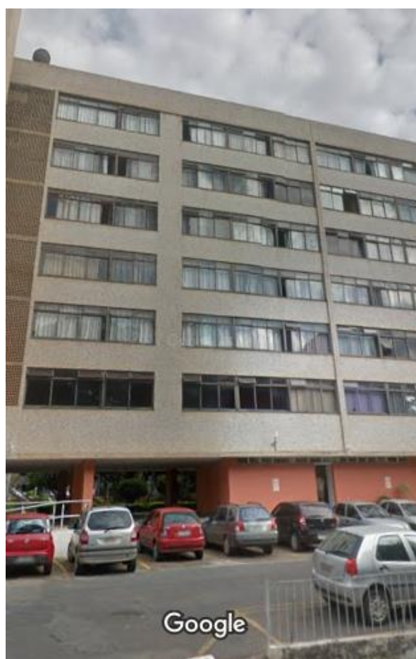
Figura 40: Fachada Sul Edifício B (MAPS, 2019).
