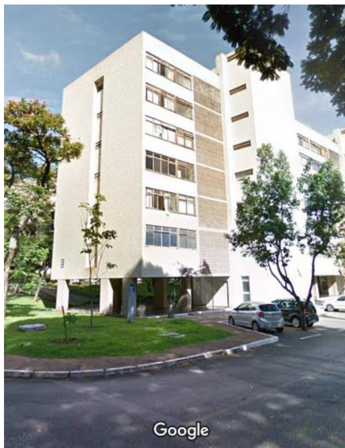
Figura 45: Fachada Sul Edifício C (MAPS, 2019).
