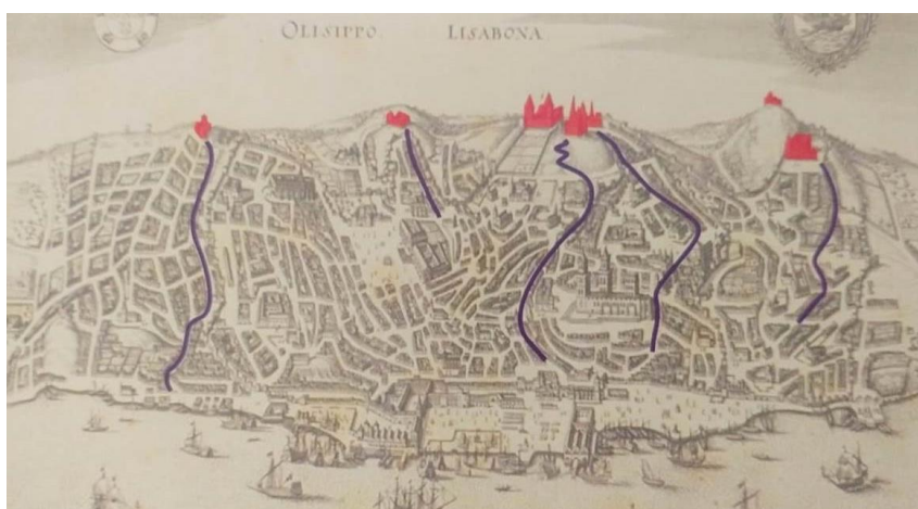
Figura 11 – Lisboa, Portugal. Ruas construídas sobre as linhas de cumeada, orientadas para edifícios localizados em posições dominantes
