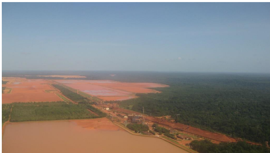
Figura 3. 20 - Vista aérea de tanques de disposição dos rejeitos da lavagem de bauxita.
