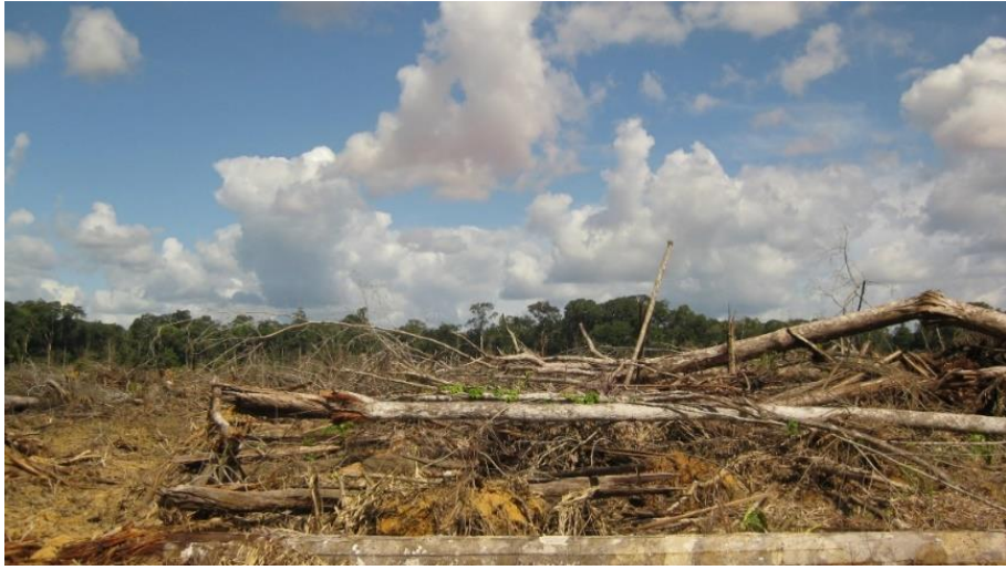
Figura 3. 15 - Operação de desmatamento.
