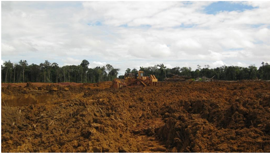
Figura 3. 16 - Operação de decapeamento (remoção de horizontes superficiais).
