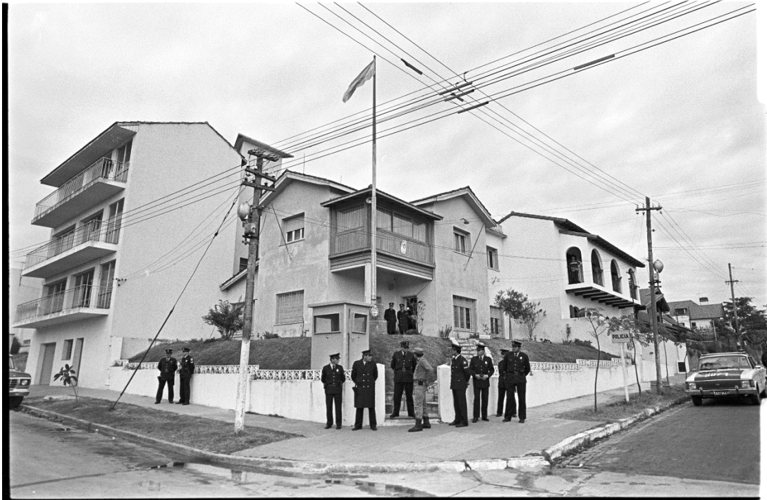
Figura 54 - Fotografía Pozo de Quilmes
