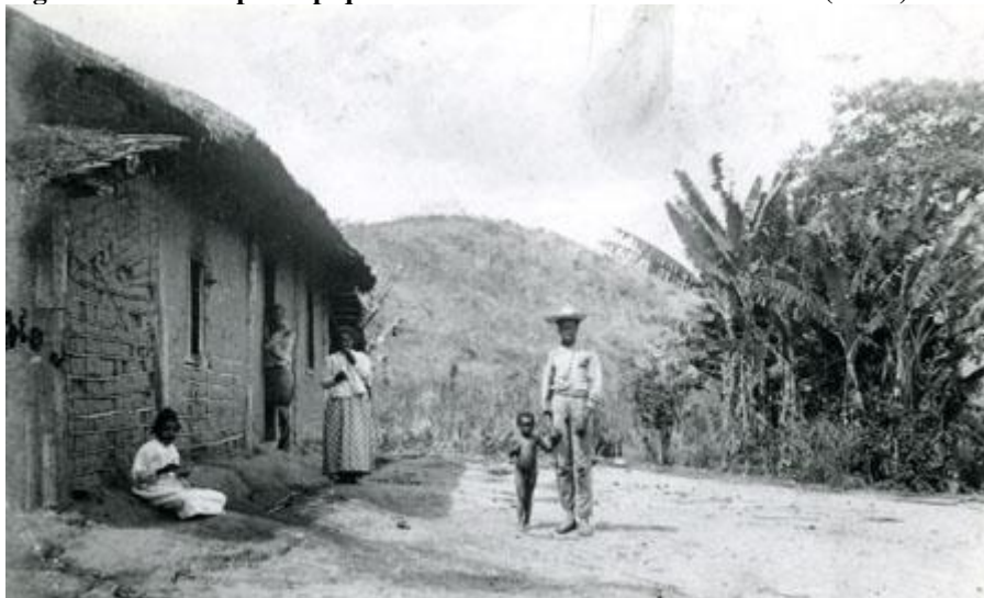
Figura 1: Casa de pau a pique de um caboclo do Vale do Paraíba (1913.)
