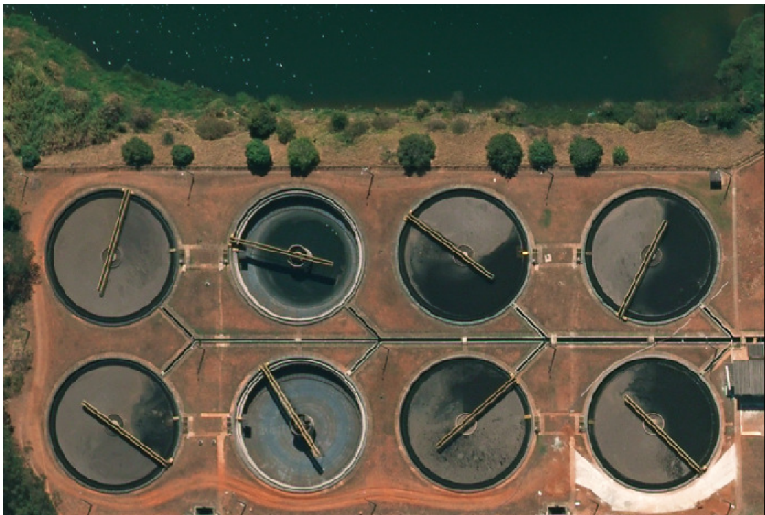
Figura 2.4: Reservatório da CAESB
