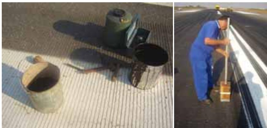
Figura 5.6. Processo de recuperação dos buracos: (a) material utilizado; (b) compactação manual.
