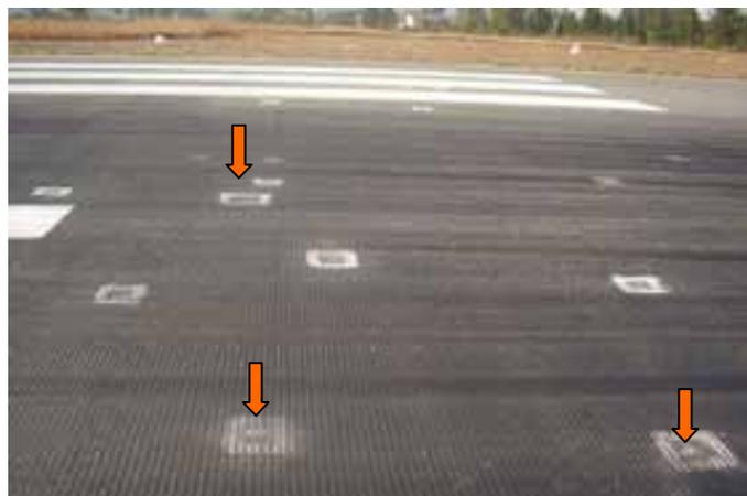
Figura 5.5. Identificação de pequenos buracos na pista do AIB (2007).
