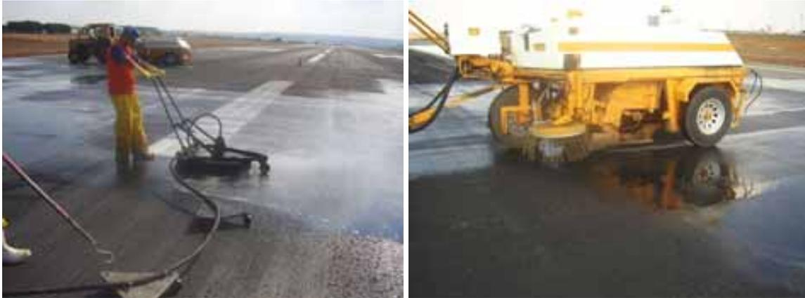
Figura 4.23. Desemborrachamento da pista do AIB: (a) chuveiro rotativo; (b) remoção dos detritos na Pista do AIB (2007).
