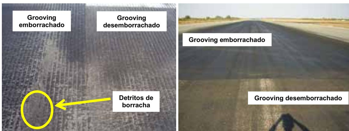
Figura 4.24. Diferença entre locais contaminados e locais recém desemborrachados na pista do AIB: (a) perfil longitudinal; (b) perfil transversal.
