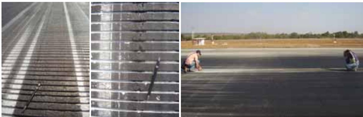
Figura 5.1. (a) e (b) Trincas longitudinais na pista do AIB; (c) processo de medição.
