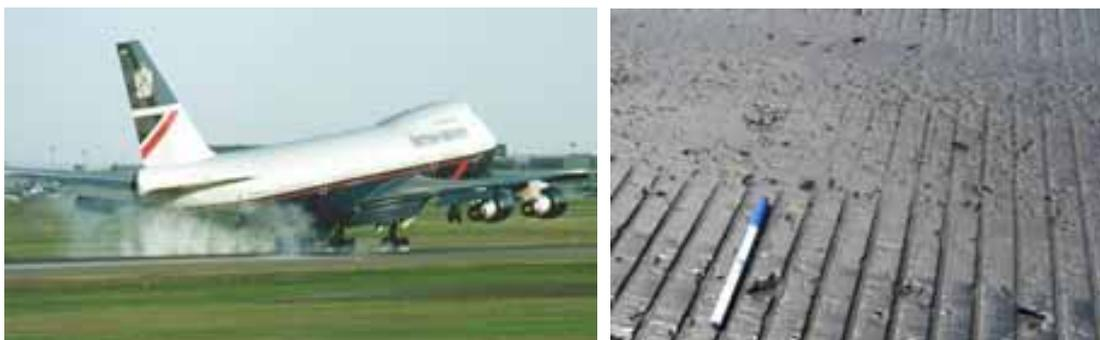
Figura 3.8. (a) Aeronave pousando; (b) Grooving emborrachado.
