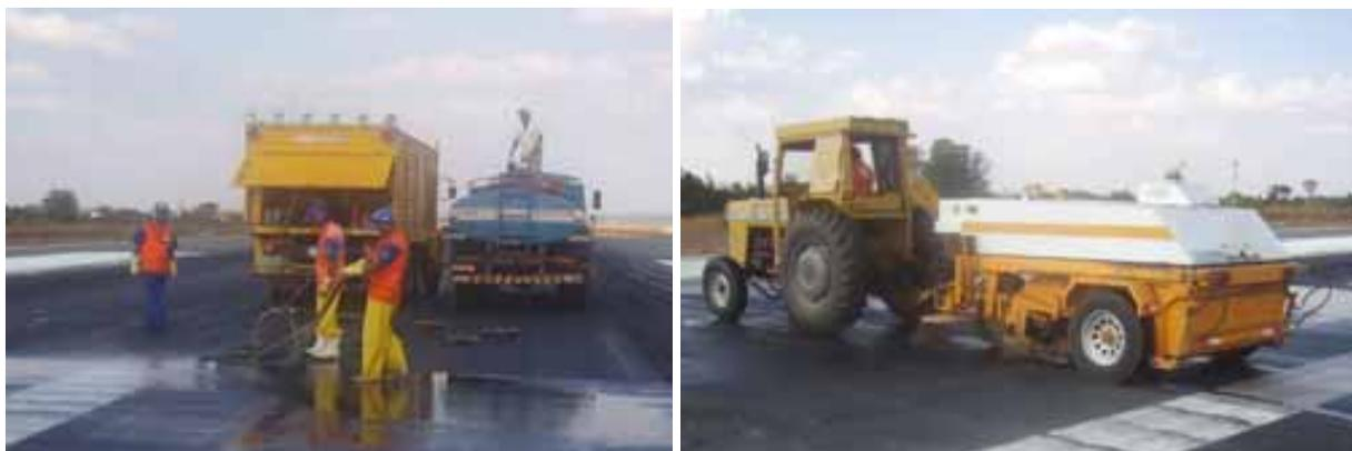
Figura 3.10. (a) Jato d'água; (b) remoção de resíduos de borracha.
