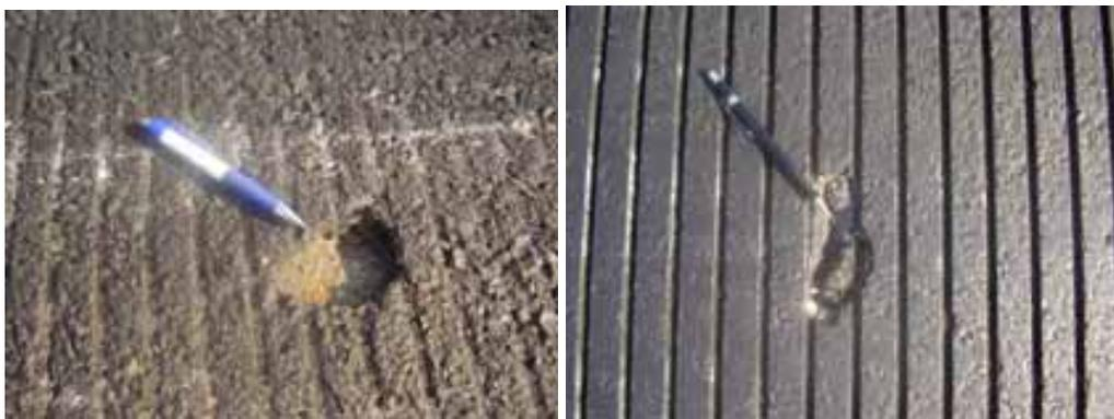
Figura 5.4. Buracos na superfície do pavimento: (a) devido ao desgaste; (b) devido à presença de objetos estranhos.
