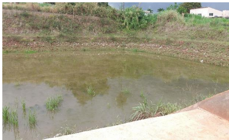
Figura 5 – Lagoa de contenção em Vicente Pires.
