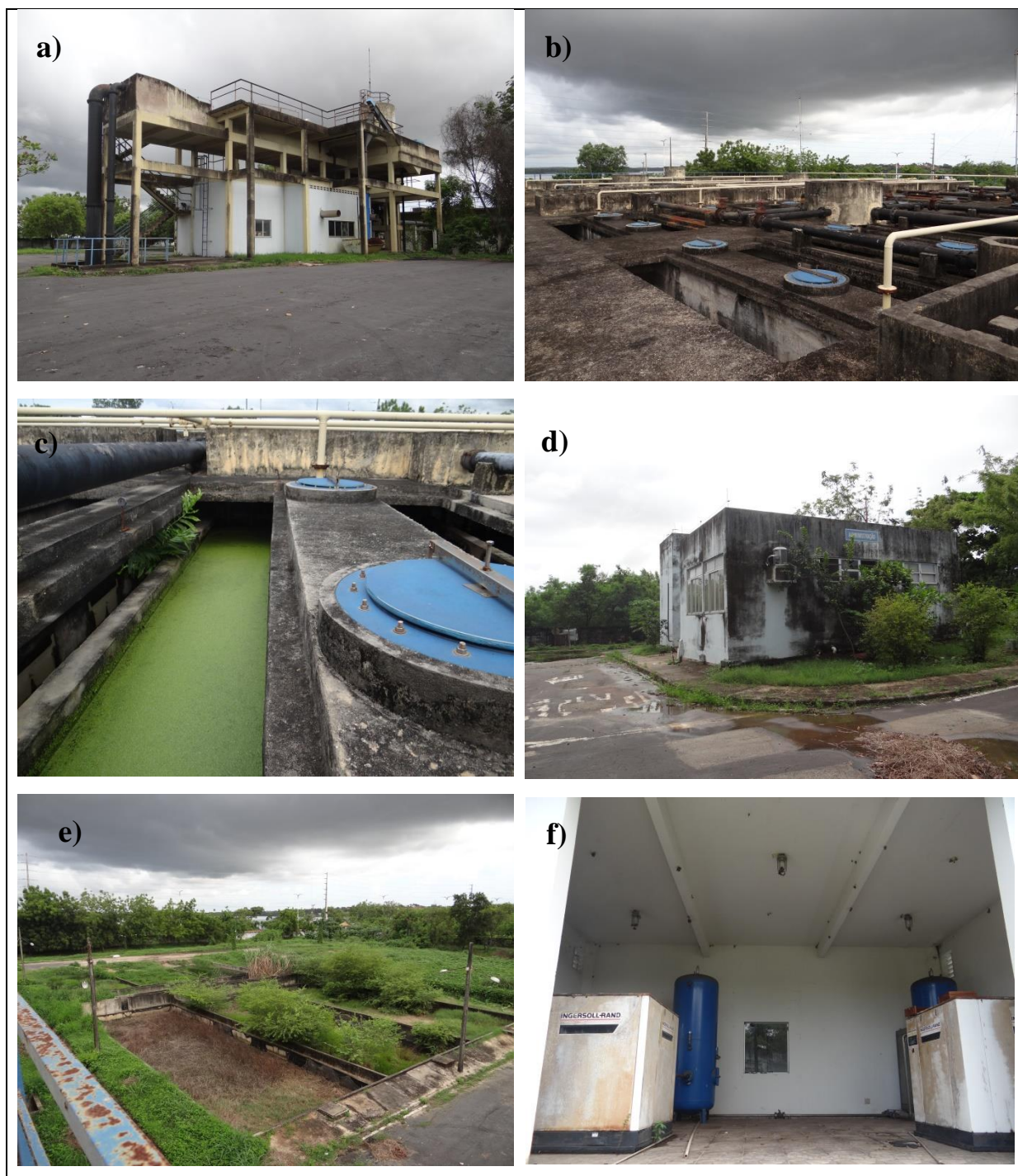
Figura 44 - Fotos da Estação de Tratamento Bacanga, sendo que: a) Tratamento preliminar; b) Reatores (tratamento primário); c) Lodo parado nos reatores; d) Casa da Administração; e) Tanques de secagem com crescimento de vegetação; f) Casa de ozonização em detalhe infestação de maribondos no teto. Fonte: Autoria própria.
