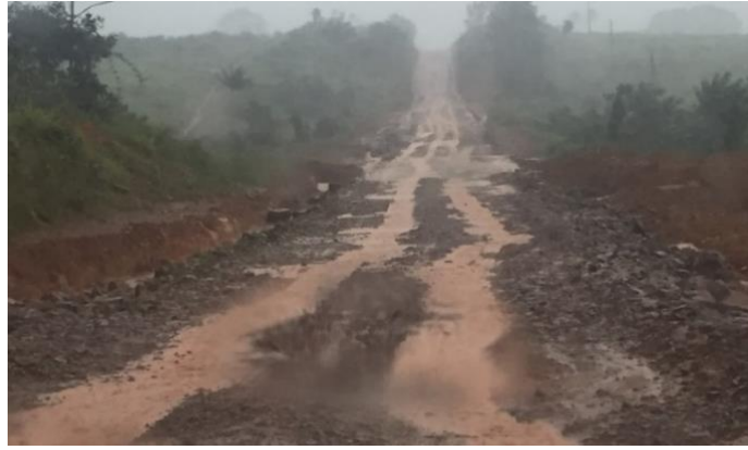
Figura 2.4: Trilha de roda na BR-163/PA.
