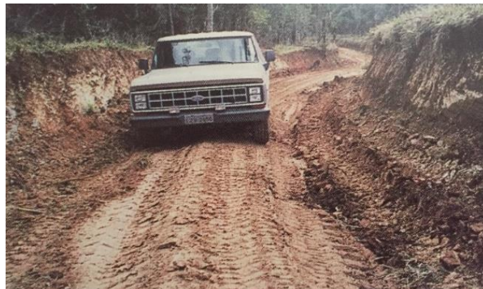
Figura 2.1: Seção transversal imprópria (Baesso & Gonçalves, 2003).
