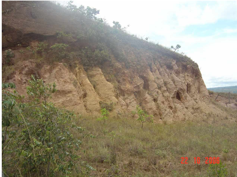
Figura 6.20 - Visão geral talude com erosão - cd. S 16° 01' 28,87" e W 48° 05' 34,82"
