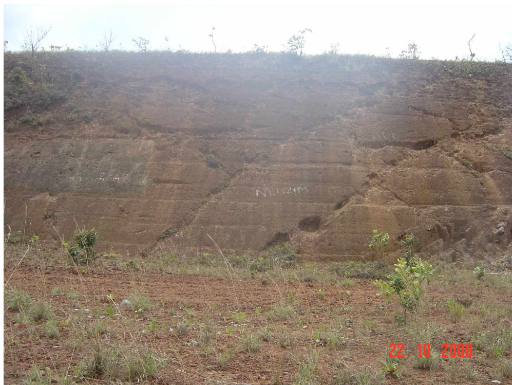
Figura 6.19 - Visão geral do talude sem erosão – cd. S 16° 01' 28,87" e W 48° 05' 34,82"
