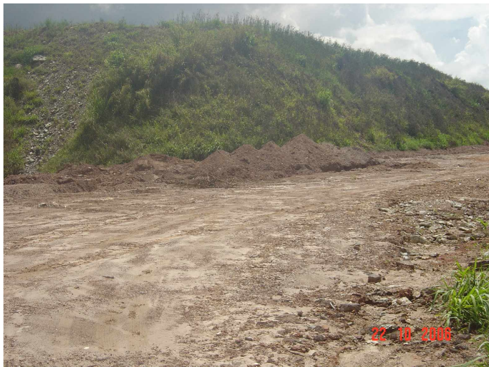
Figura 6.15 - Visão geral do talude sem erosão - coord. S 16° 00' 48,70" e W 48° 09' 52,94"
