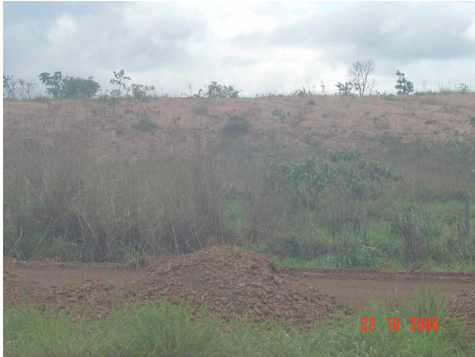
Figura 6.10 - Visão geral do trecho com erosão - coord. S 16° 06' 41,87" e W 48° 18' 20,97"
