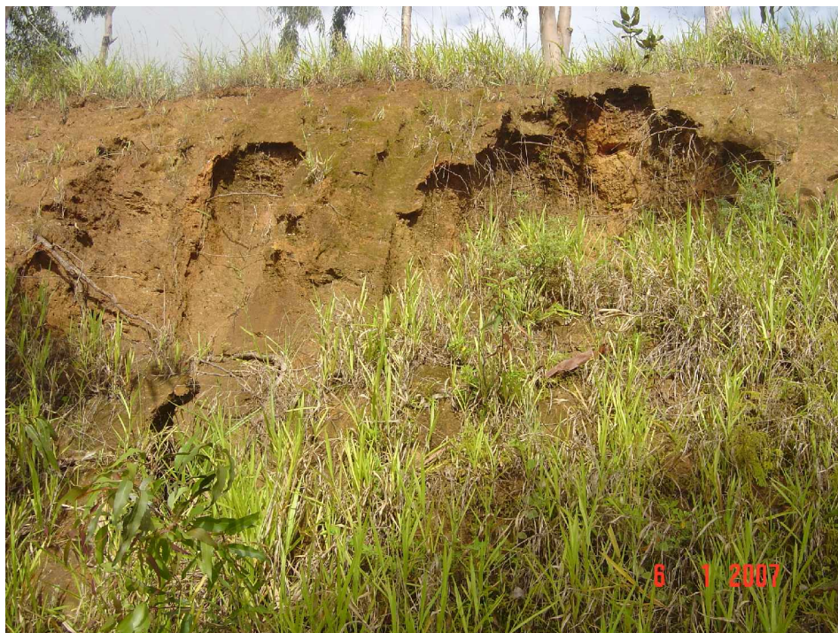
Figura 6.3 - Detalhe do ponto de coleta 32 (em local com a presença de processos erosivos).
