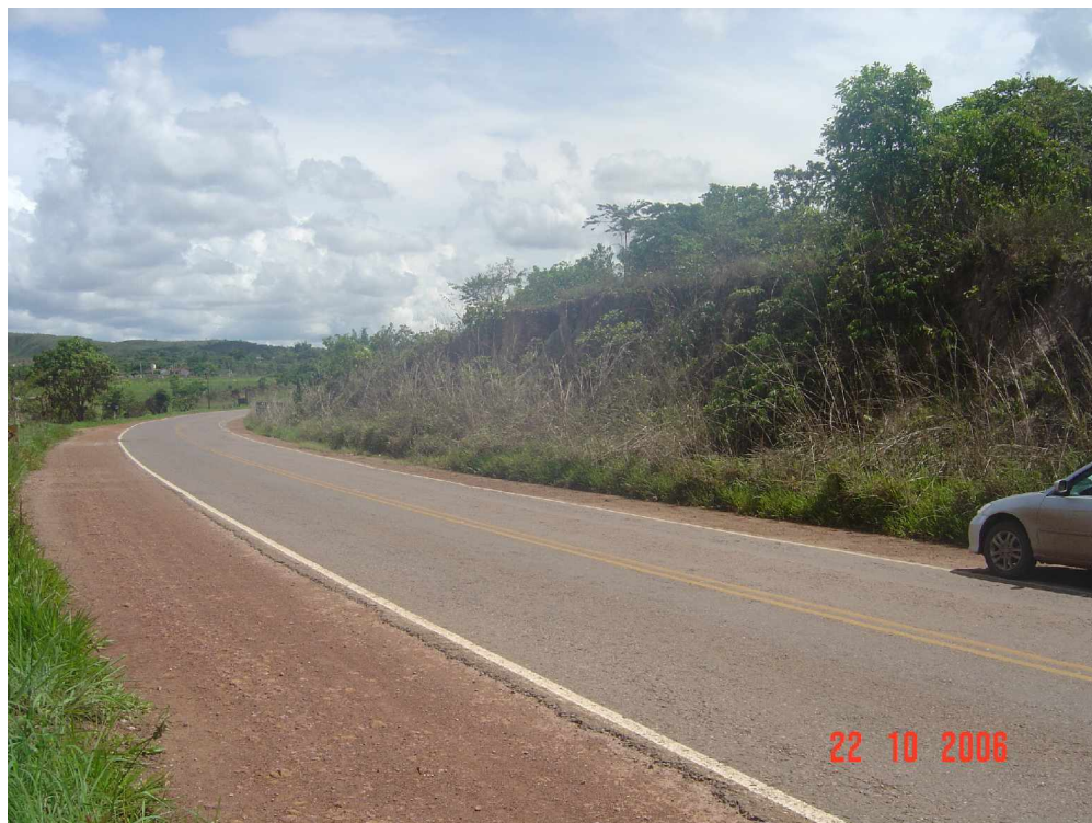
Figura 6.23 - Visão geral do talude sem erosão – cd. S 15° 33' 36,03" e W 48° 11' 48,61"
