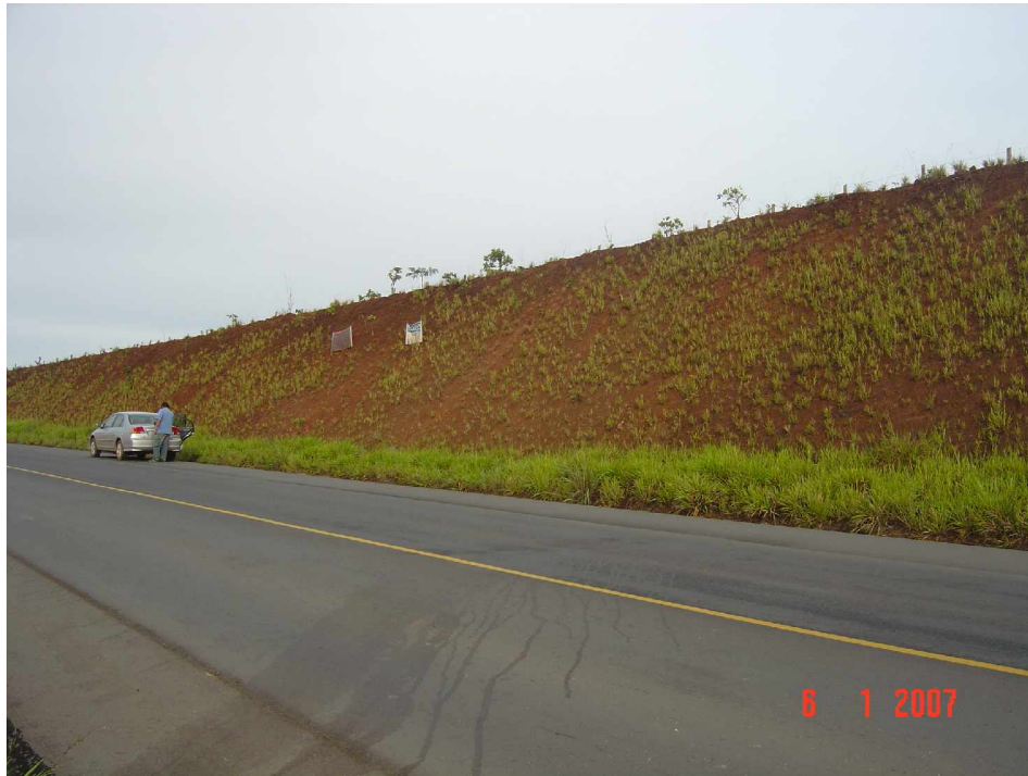
Figura 6.2 - Detalhe do ponto de coleta 31 (em local sem a presença de processos erosivos).
