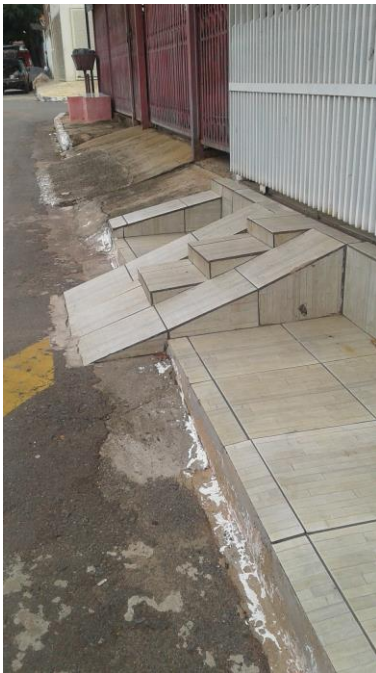
1015 Figura 8: Imagens mostrando diversos tipos de obstruções nas calçadas da Vila Planalto. Muretas e Portões invadindo o espaço dos pedestres, presença de postes de luz, lixeiras e rampas obstruindo a passagem e ausência de acessibilidade universal.
