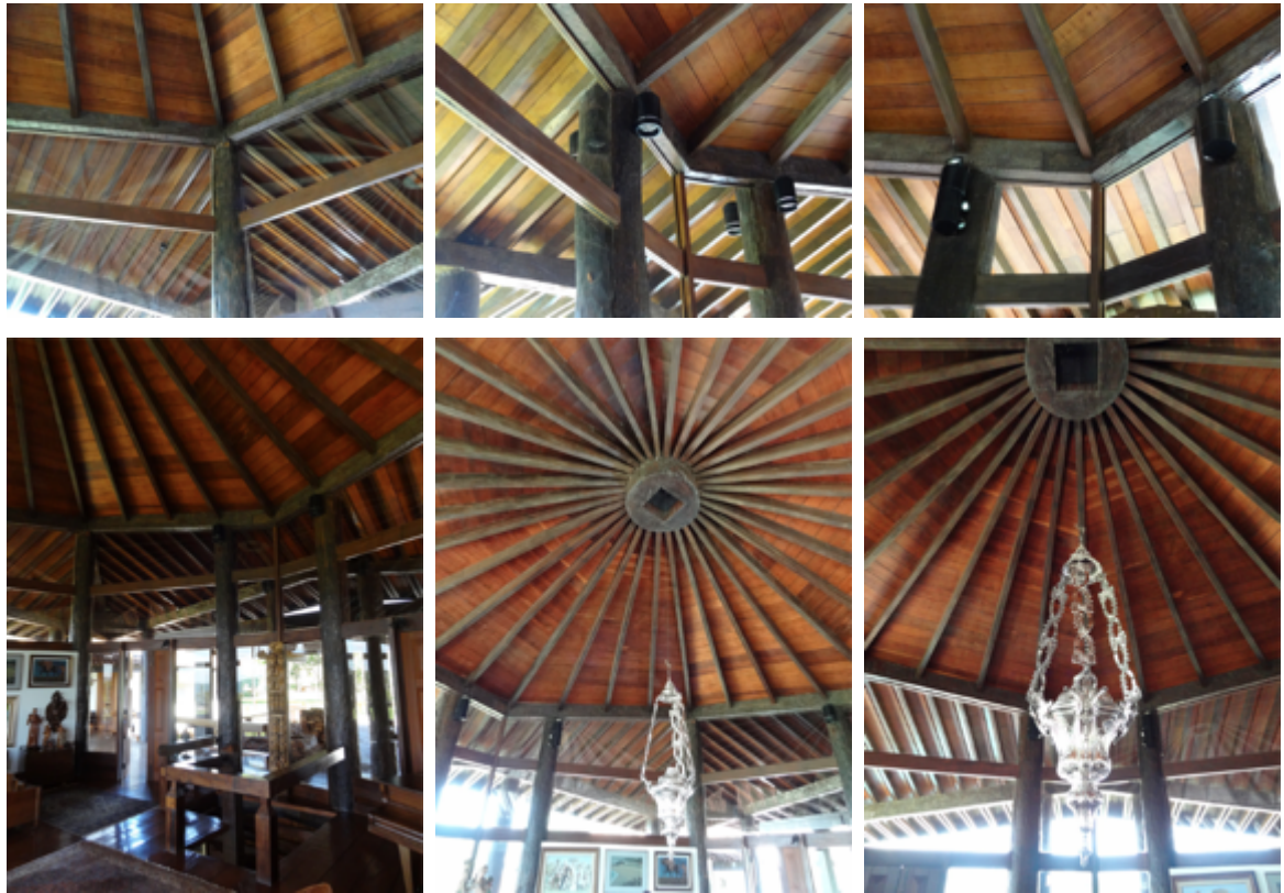
Figuras 150, 151, 152, 153, 154, 155: vistas dos detalhes do telhado da sala central do pavimento superior
