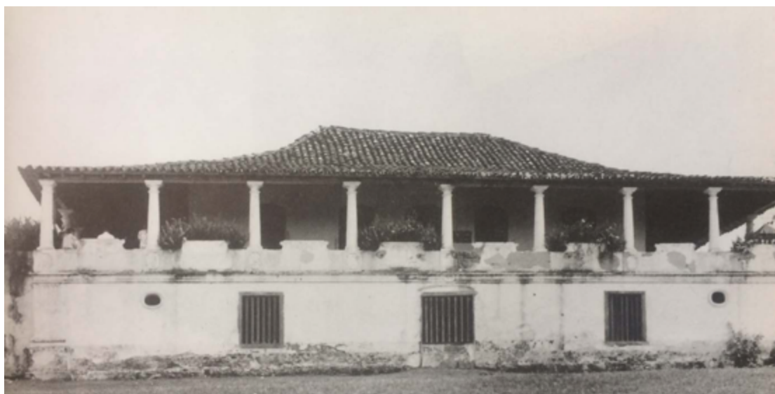
Figura 129: vista frontal da Fazenda Colubandê em estilo colonial tradicional com telhado cerâmico
