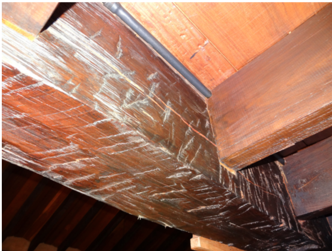
Figura 148: detalhe de viga central feita por tecnologias tradicionais e arcaicas com o uso do exõe,
