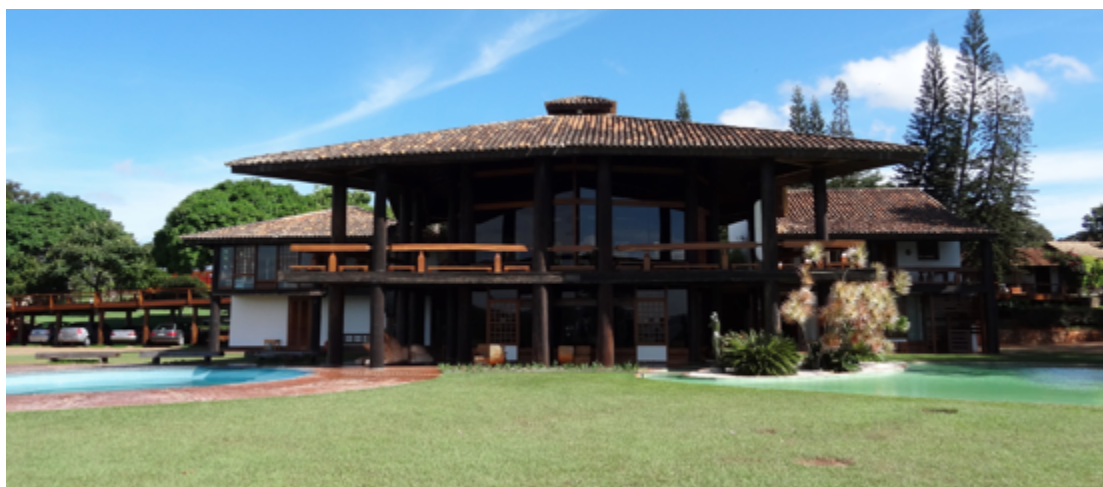
Figura 131: vista frontal da casa a partir do lago em que estão localizados os três volumes de construção
