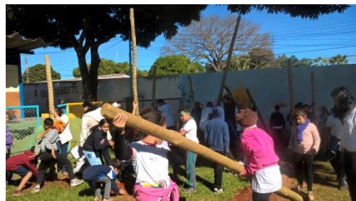
Figura 31: construção do viveiro, EC 05, 05/07/2017.
