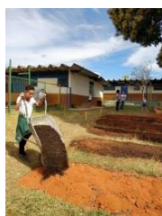
Figura 41: construção da horta, EC 05, 08/08/2017.
