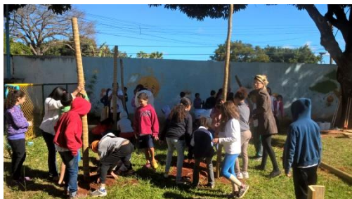
Figura 30: construção do viveiro, EC 05, 05/07/2017.
