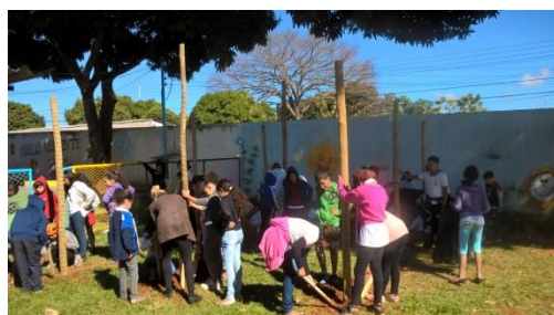
Figura 32: construção do viveiro, EC 05, 05/07/2017.
