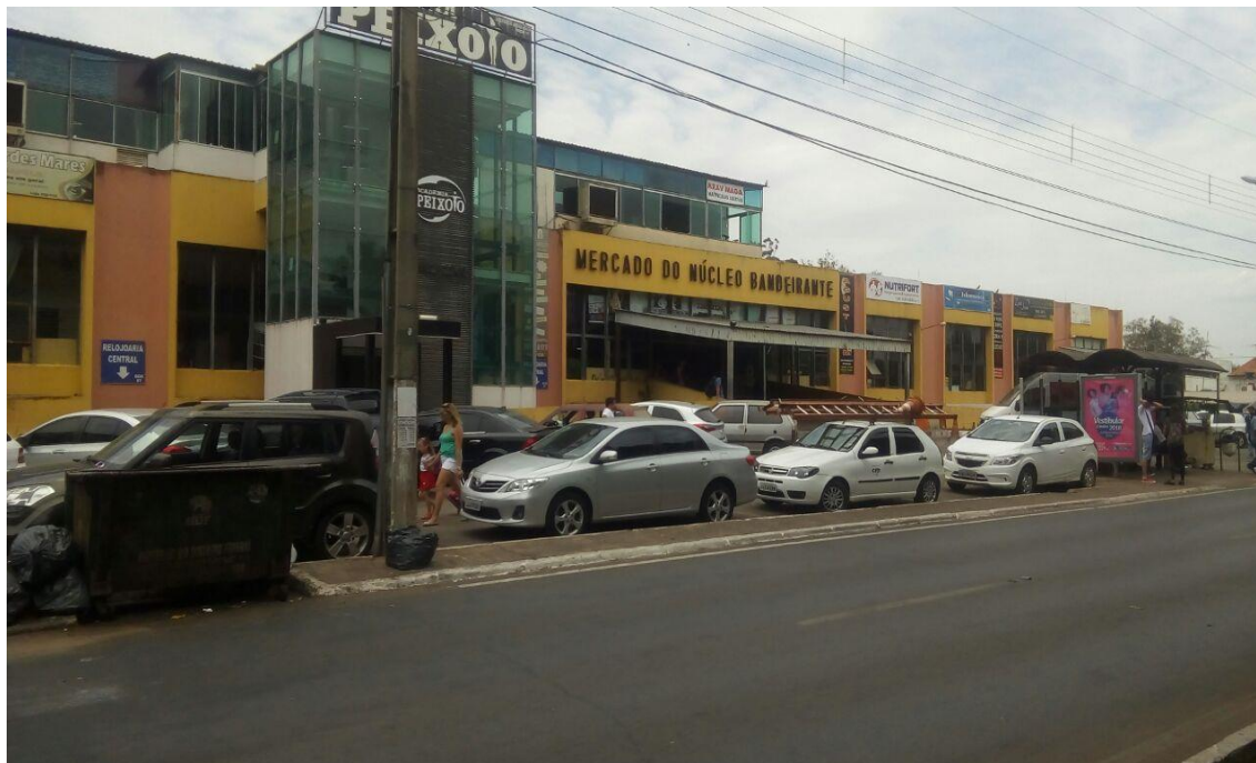
Figura 3.13. – Fachada principal do Mercado do Núcleo Bandeirante
