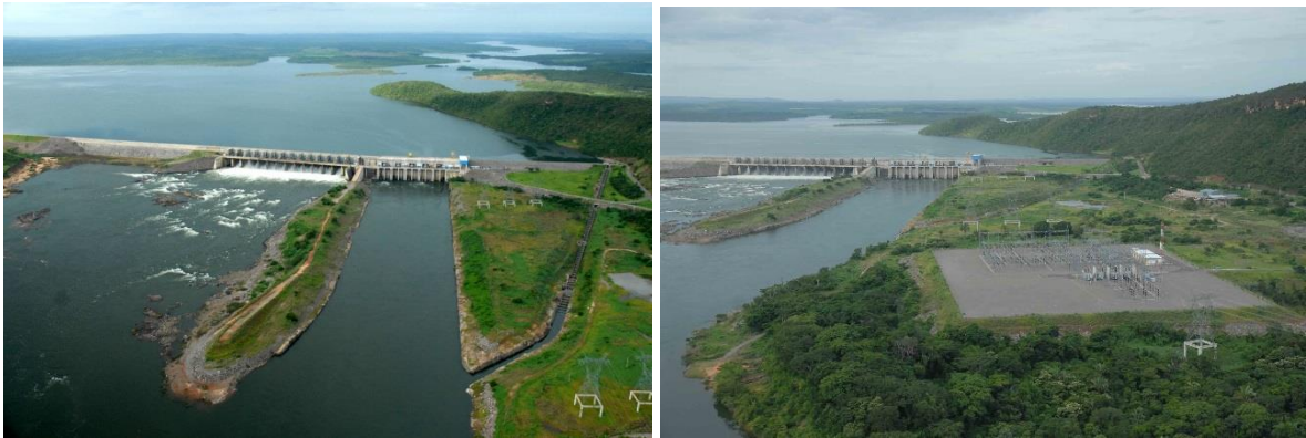
Figura 3.7 Usina Hidrelétrica Luís Eduardo Magalhães - UHE Lajeado (Investco, 2017)
