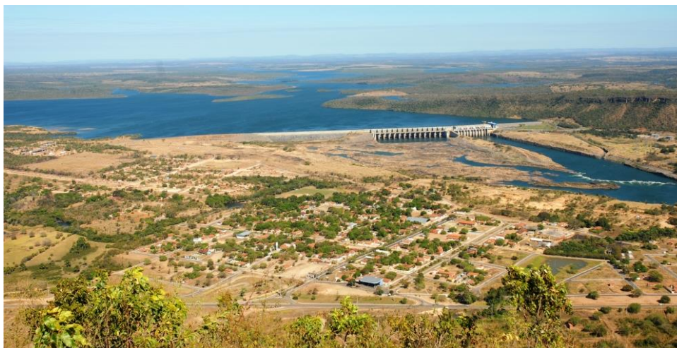
Figura 5.2 Lajeado e a UHE Luís Eduardo Magalhães, vista do mirante da Serra do Lajeado (Turismo do Estado do Tocantins, 2017)
