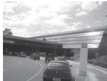
Fachada principal do edifício
