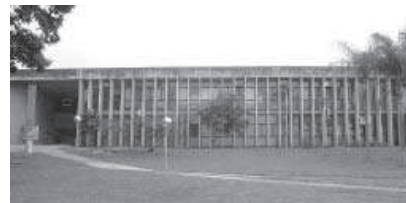
Vista externa do edifício (fachada sul)
