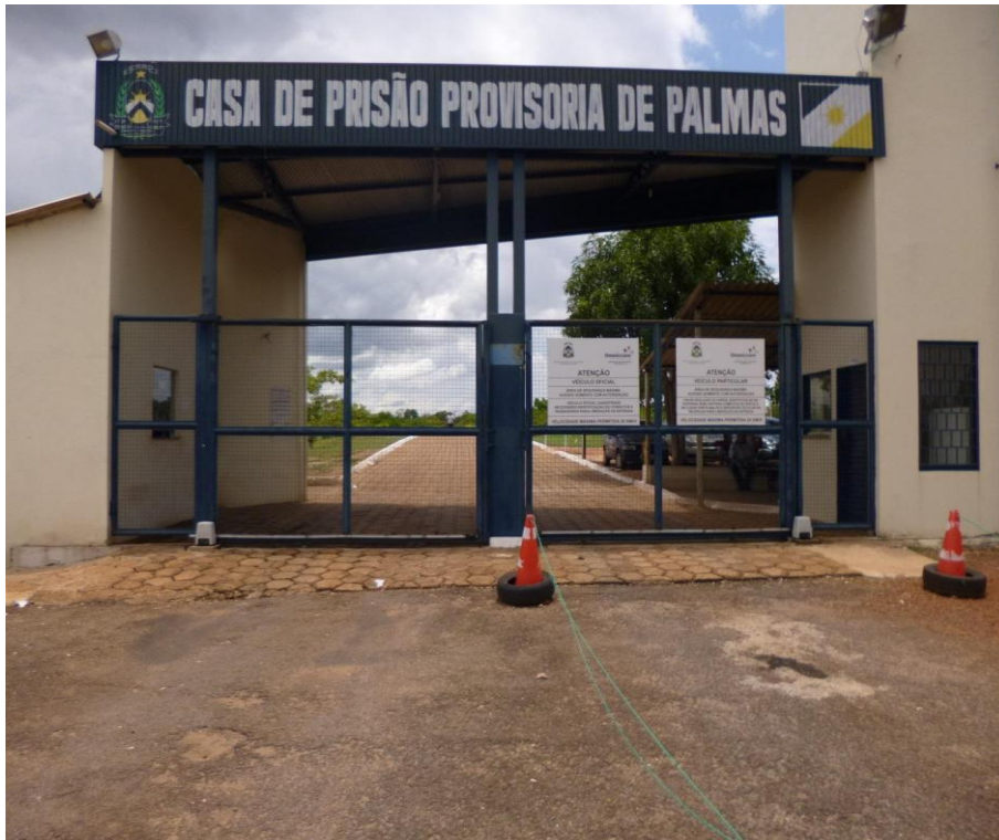
Ilustração 1 - Portão de acesso à CPP
