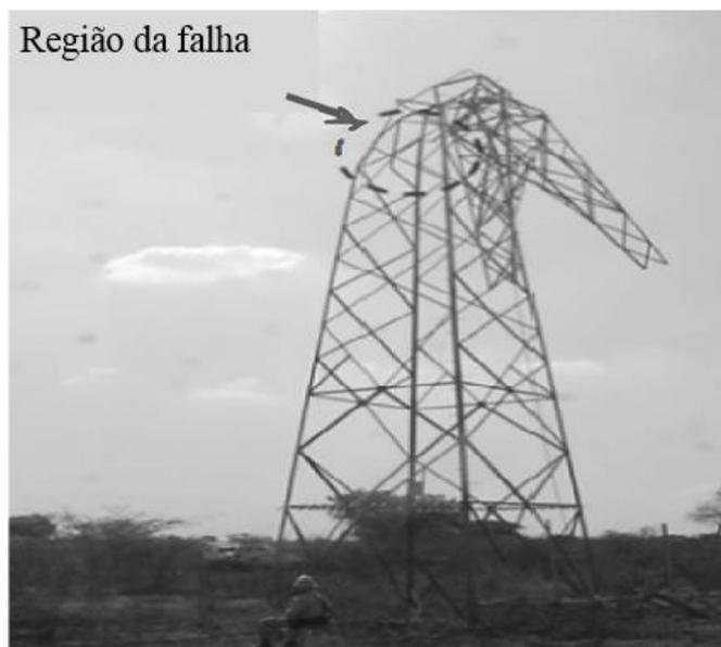
Figura 1.1 – Torre de 110 kV rompida devido a falha do condutor (1)
