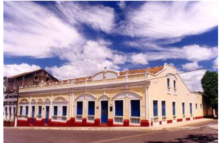
Figura 4.99 – Solar dos Pinho Pessoa, em Viçosa do Ceará – CE.
