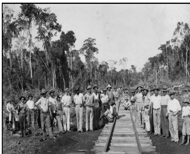
Figura 13 – Construção da estrada de ferro Fonte: Prefeitura Municipal de Maringá (sem data)
