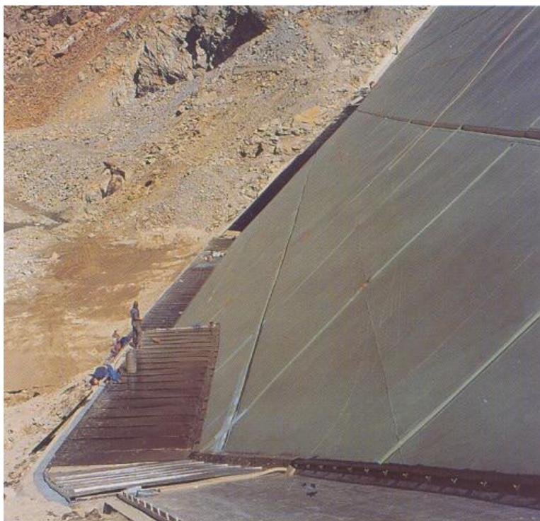
Figura 4.33 – Proteção adicional ao longo da junta perimetral (Catálogo Carpi, S/D).
