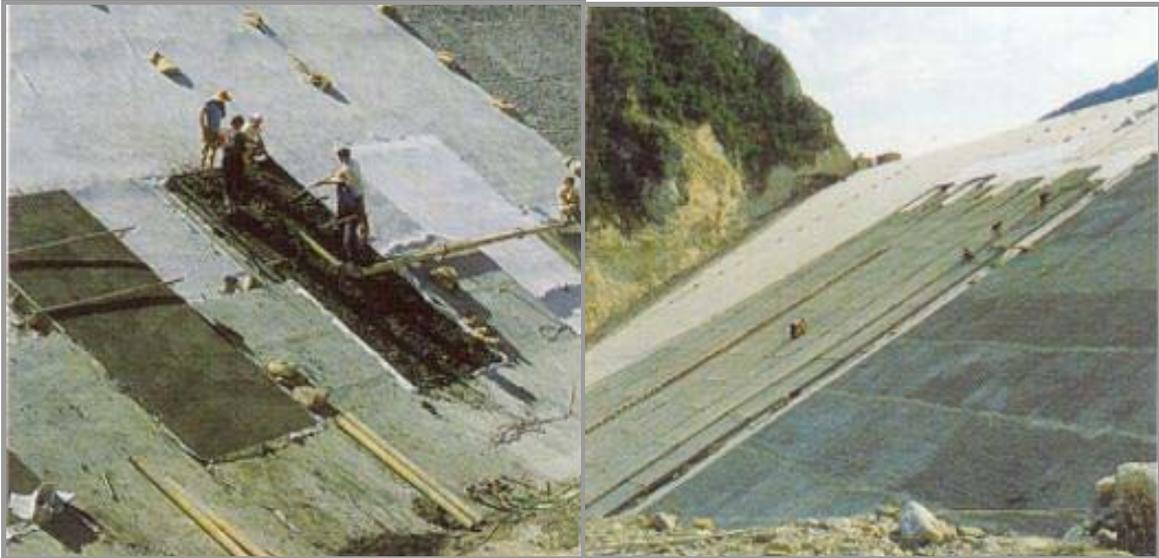
Figura 4.36 – Execução da laje de proteção na Barragem de Bovilla (Catálogo Carpi, S/D).
