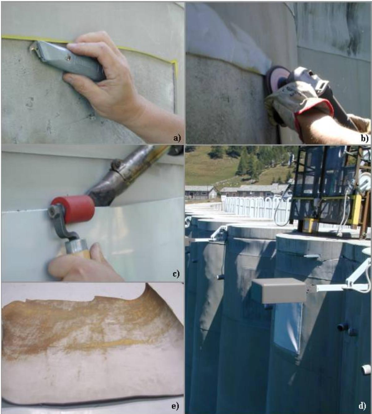
Figura 7.1 – Procedimento de exumação de uma amostra de geocomposto na Barragem de Ceresole Reale: a) corte; b) lixamento da superfície a ser soldada; c) solda por termo-fusão; d) vista geral da emenda; e) amostra coletada.
