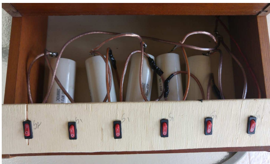
Figura 24 – Implementação do banco de capacitores alternável embutido na caixa suporte das Bobinas de Helmholtz
