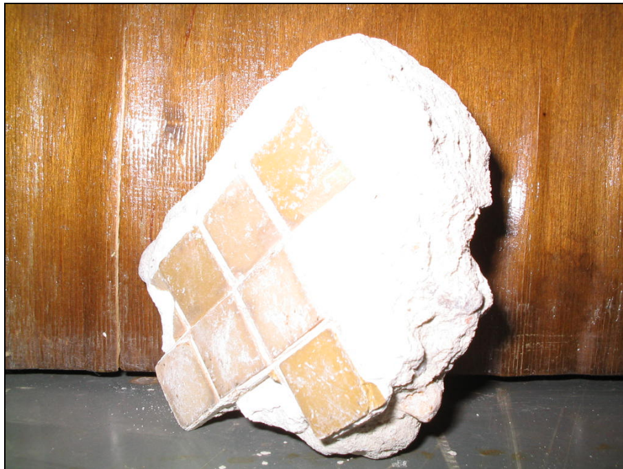
Fotografia 3.15 – Detalhe de elemento formado por componentes cerâmico e argamassado.
