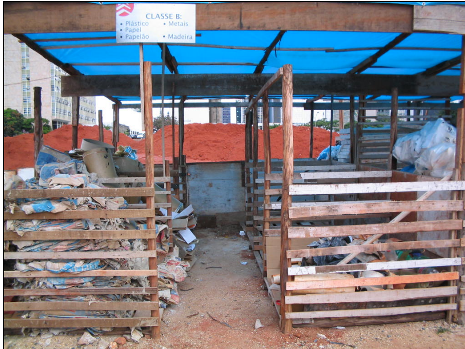
Fotografia 4.1 – Baias de armazenamento temporário de RSCD no canteiro EC-7/CO-1.
