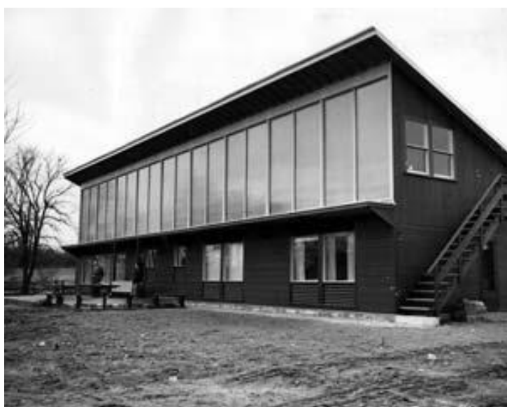
Fig. 35. Dover Sun House, 1948 - Eng. Maria Telkes Primeira residência moderna aquecida por energia solar Fonte: libguides.mit.edu
