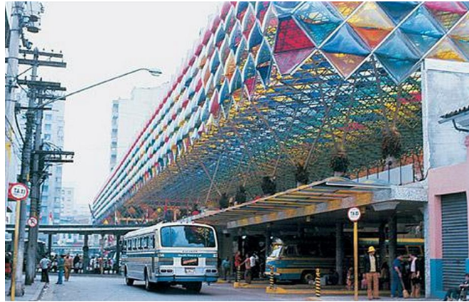
Fig. 13 Material Compósito - Estação Rodoviária da Luz, São Pulo, 1961. Fonte: Vitruvius.com
