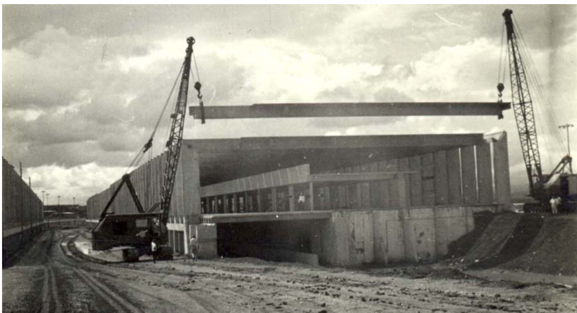
Figura 4.10: Colocação da viga isostática de cobertura. (Cedoc, 2006)
