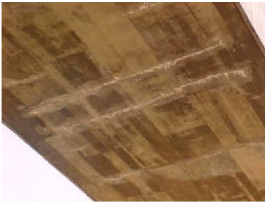
Fig. 18 – Eflorescência ( F_i=3 )
