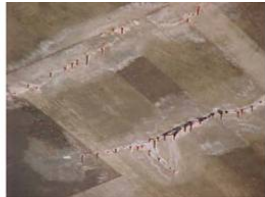
Fig. 11 - Corrosão ( F_i=3 )
