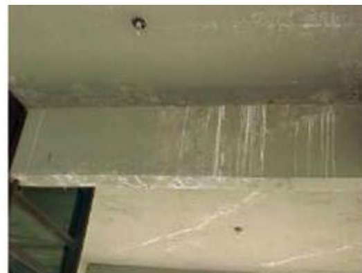
Fig. 17 - Eflorescência ( F_i=2 )
