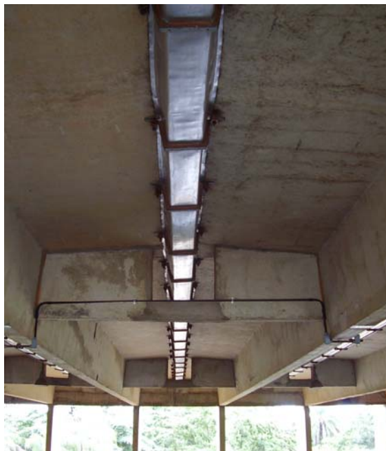
Figura 4.12: Septos Transversais de enrijecimento. (CEPLAN, 2006)
