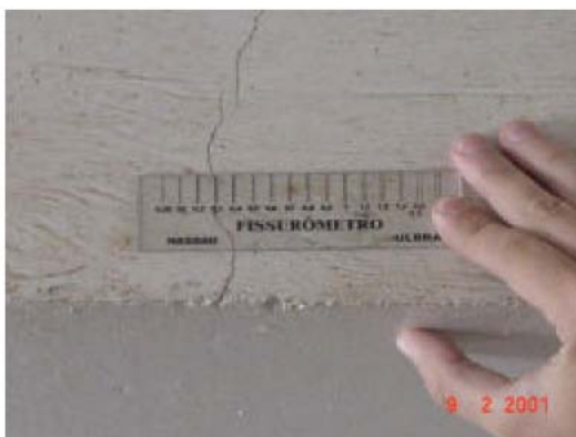
Fig. 23 – Fissura ( F_i=3 )
