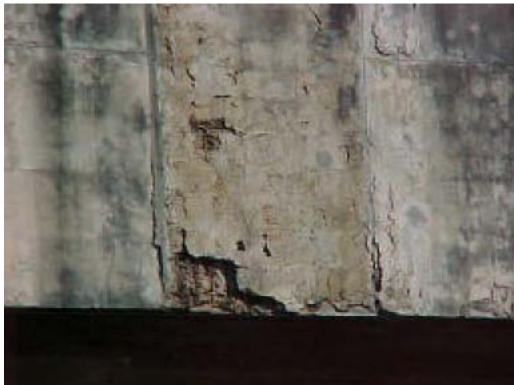
Fig. 8 - Corrosão ( F_i=4 )
