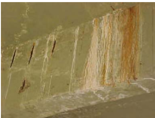
Fig. 19 – Eflorescência ( F_i=4 )
