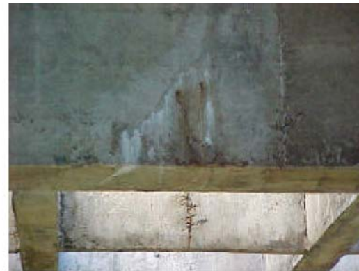
Fig. 16 - Eflorescência ( F_i=1 )
