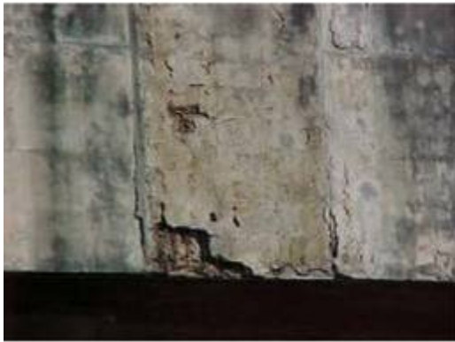
Fig. 8 - Corrosão ( F_i=4 )
