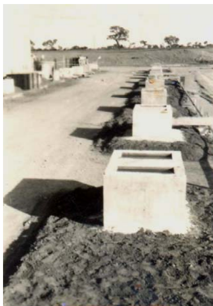
Figura 4.8: Cavidades nas sapatas para receber os pilares. (Cedoc, 2006)
