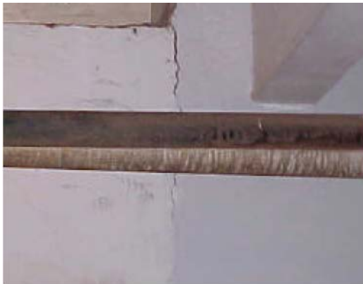
Fig. 24 - Fissura ( F_i=3 )
