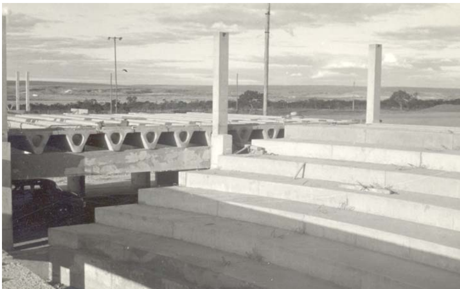
Figura 4.14: Detalhe das vigas Trapezoidal vazada e Degraus do Auditório. (Cedoc, 2006)
