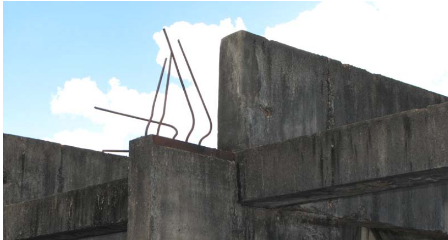
Figura 4.11: Armaduras de espera nos pilares. (2006)
