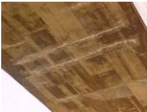
Fig. 18 - Eflorescência ( F_1=3 )
