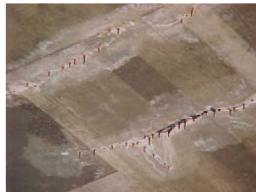
Fig. 11 - Corrosão ( F_i=3 )
