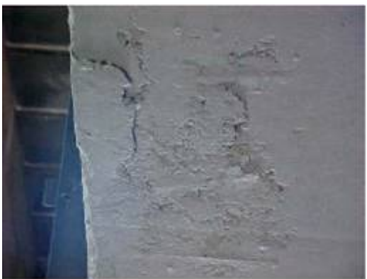
Fig. 20 - Esfoliação ( F_1=2 )
