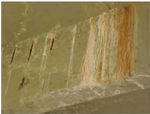
Fig. 19 - Eflorescência ( F_1=4 )
