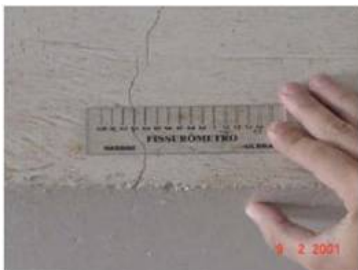
Fig. 23 - Fissura ( F_1=3 )
