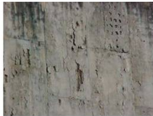
Fig. 21 - Esfoliação ( F_1=3 )
