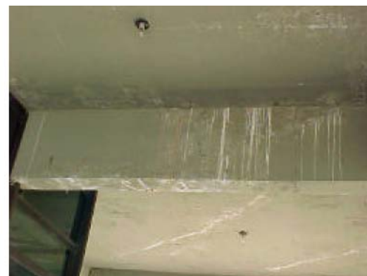
Fig. 17 - Eflorescência ( F_i=2 )
