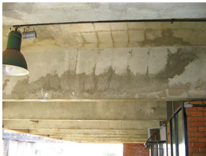
Figura 5.8: Umidade na alma e mesa de viga. (Andrade, 2006)
