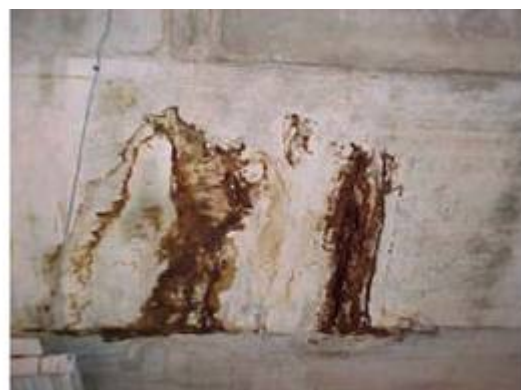
Fig. 6: Corrosão ( F_i=3 )
