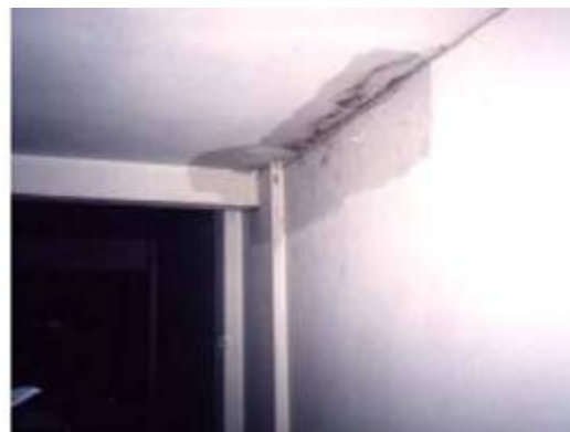
Fig. 28 - Infiltração ( F_i=2 )
