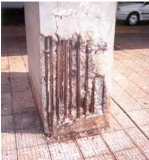
Fig. 9 - Corrosão ( F_i=4 )
