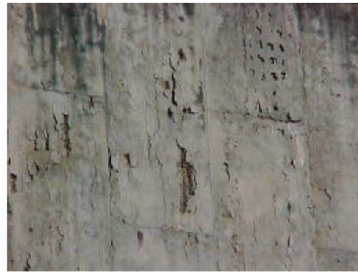
Fig. 21 – Deslocamento ( F_i=3 )
