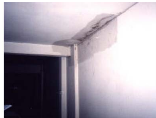
Fig. 28 - Umidade ( F_i=2 )
