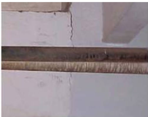
Fig. 24 - Fissura ( F_i=3 )
