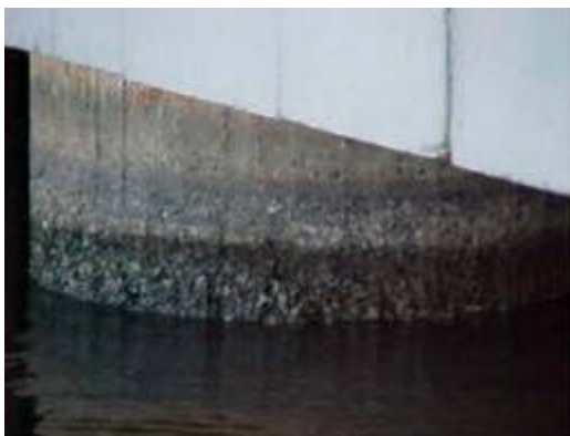
Fig. 14 - Desagregação ( F_i=3 )
