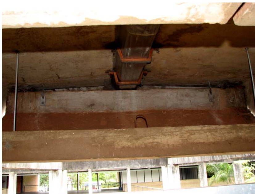
Figura 4.21: Tirantes de sustentação das platibandas. (2006)
