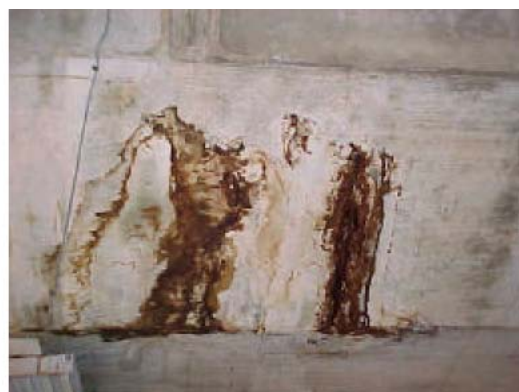
Fig. 6: Corrosão ( F_i=3 )
