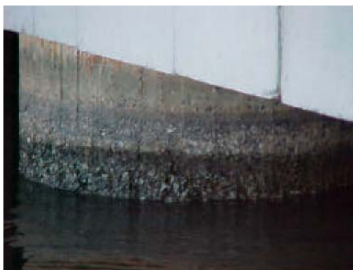
Fig. 14 - Desagregação ( F_i=3 )
