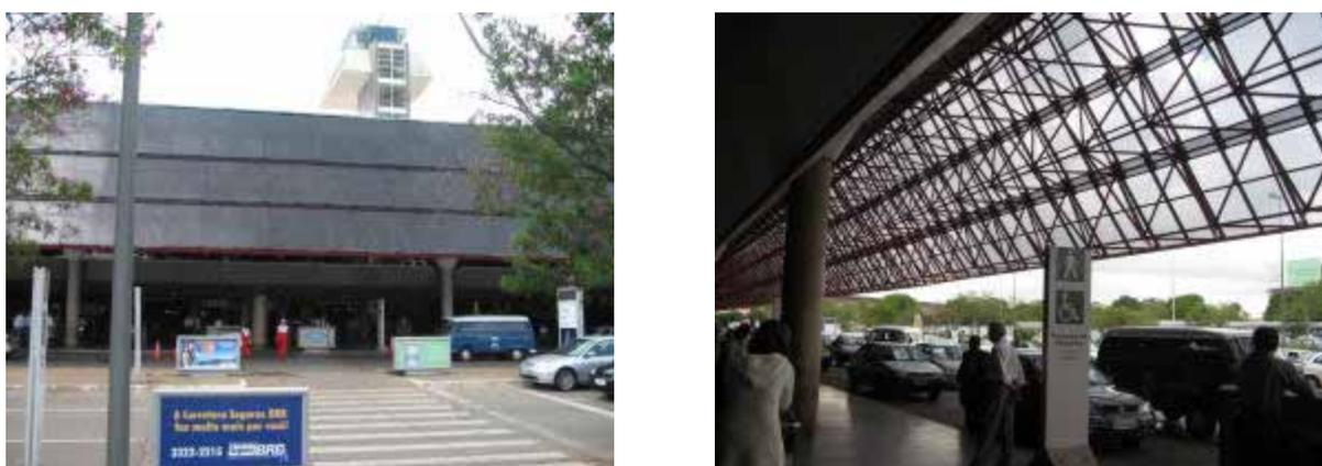
Figura 46 - AIB – Fachada de acesso principal Lado Terra – (a) vista externa (b) vista interna - de onde se vê os elementos transparentes da fachada sobre estrutura espacial metálica, que favorecem a captação de iluminação e ventilação. (Foto da autora, 2006)
