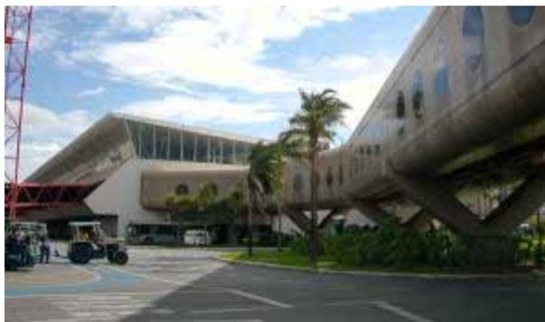
Figura 42 -AIB – fachada leste. O elemento de concreto faz a ligação do bloco principal do terminal de passageiros (segundo plano) com o satélite de embarque norte. Observar as fachadas envidraçadas do terraço panorâmico no terminal e o avanço do beiral na fachada voltada para o lado ar. (Foto da autora, 2006)
