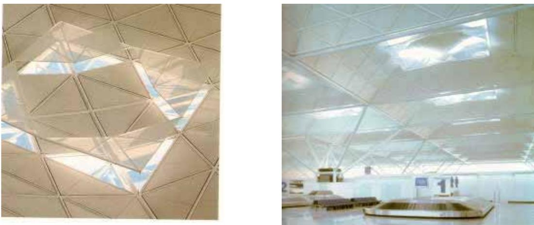
Figura 16 - Detalhe (esq) e vista (dir) do conjunto da estrutura de cobertura do Aeroporto Stansted, no Reino Unido, mostrando os dispositivos de controle de luz natural (LOE; MANSFIELD, 1997)
