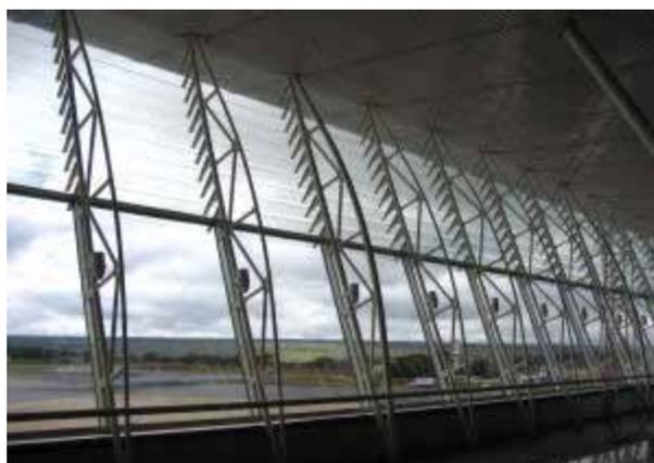
Figura 43 -AIB – fachada leste. Vista interna do fechamento transparente do terraço panorâmico, que também serve de mirante (BRENDOLAN, 2005).
