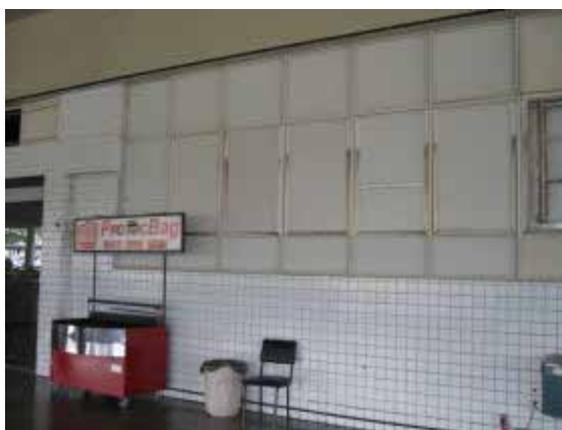
Figura 86 -ASG – barreiras à luz natural são priorizadas em função da privacidade ou segurança. Neste caso verifica-se a aplicação de película opaca em salas comerciais do saguão, na face voltada para a marquise da entrada principal. (Foto da autora, 2006)
