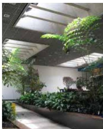
Figura 51 - Aberturas na laje entre o terraço panorâmico (superior) e o piso de embarque (inferior) são exemplos dos elementos de condução da luz natural entre os pavimentos (Foto da autora, 2006).
