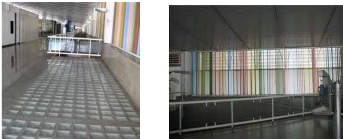
Figura 52 - (a) e (b) Transparências que filtram a luz através do painel artístico de Athos Bulcão, em chapa metálica perfurada, atenuando a incidência de luz e calor na fachada oeste ao mesmo tempo em que cumpre função estética para o local. (Foto da autora, 2006)
