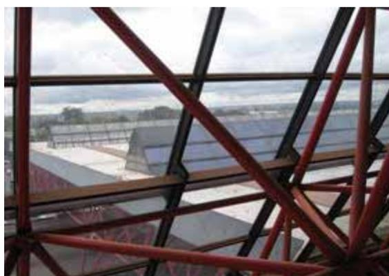
Figura 45 - Elementos de transparência que favorecem a captação de luz natural para o interior do AIB. Em primeiro plano, elemento de captação de luz lateral no terraço panorâmico e, em segundo plano, os elementos de captação de luz zenital sobre o pavimento térreo (Foto da autora, 2006)
