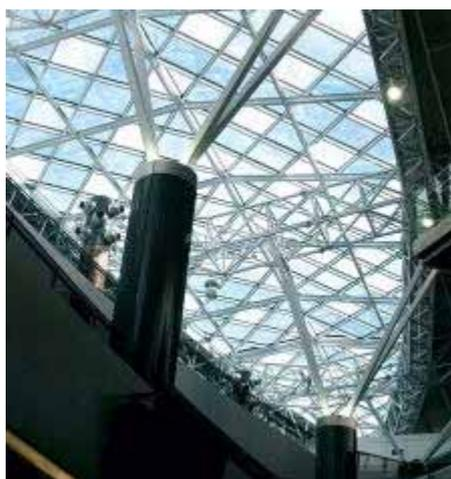
Figura 22 - Vista interna do Aeroporto de Recife mostrando parte do volume transparente da barca da cobertura captando a luz natural (ALEN, 2007)
