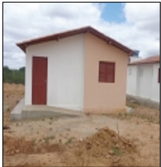
Figura 2 - Unidade Habitacional Santo André – PB (concluída) Fonte: ABC (2014).
