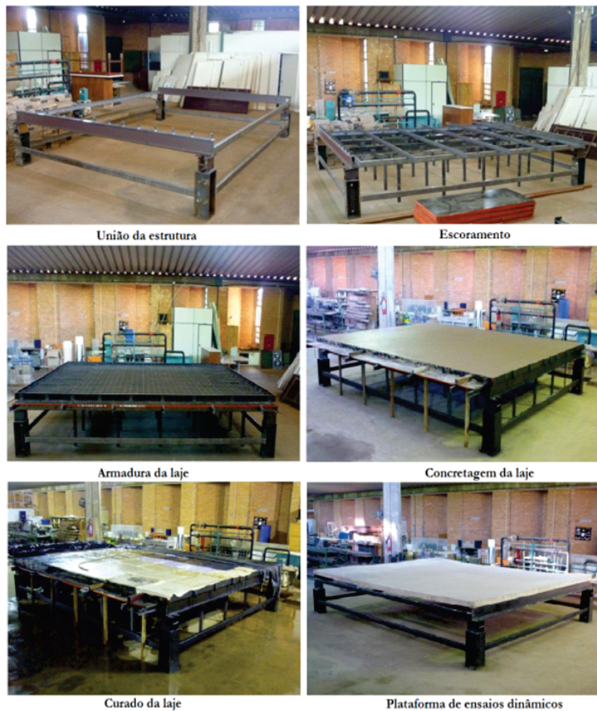
Figura 8 – Diferentes etapas de construção da plataforma de ensaios dinâmicos
