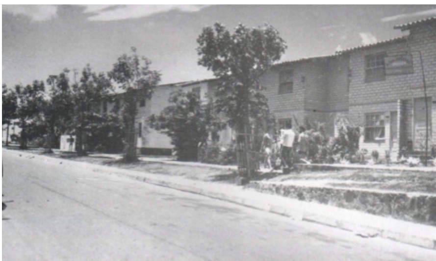
Figura 15. Conjunto Antônio Carlos Magalhães: tipologia habitacional unifamiliar de três dormitórios. Fonte: < http://www.cronologiadourbanismo.ufba.br >. Acesso em: 20 set. 2014
