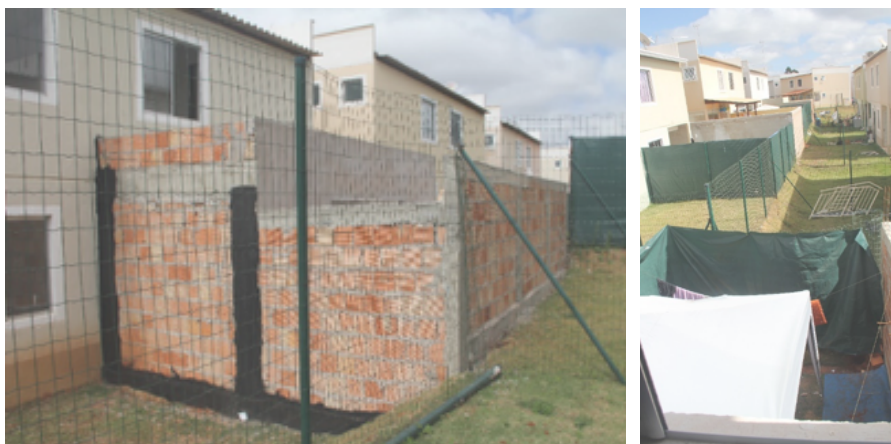
Figura 75. Setor Habitacional Mangueiral: intervenções nos fundos dos lotes.
