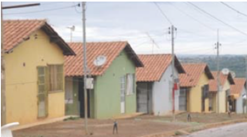
Figura 29. Conjunto Habitacional Bethel II. Foto: Marina Lima de Fontes
