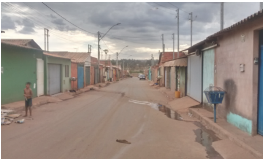
Figura 92. Setor Oeste da Cidade Estrutural: intervenções/acréscimos nas unidades habitacionais avançam sobre o passeio público.
