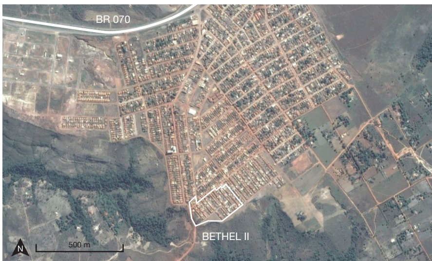
Figura 26. Conjunto Habitacional Bethel II, em Águas Lindas, GO. Desenho: Lucas de Abreu, elaborado com base em Google Earth, 2017
