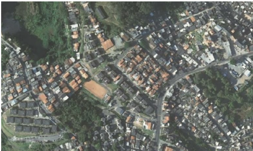
Figura 14. Conjunto Antônio Carlos Magalhães: inserção urbana. Fonte: Google Earth, 2014.
