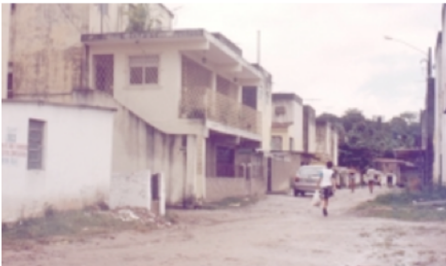
Figura 41. Conjunto Habitacional Curado III. Acréscimos realizados pelos moradores ao lado dos edifícios (ao fundo). Fonte: MONTEIRO, 2000.
