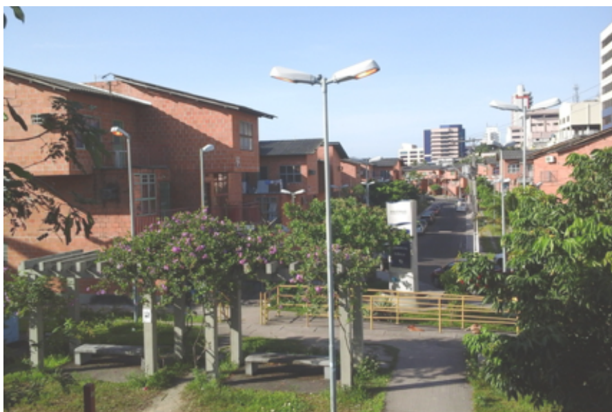
Figura 37. PROSAMIM: Parque Residencial Manaus, Quadra Bairro 3.
