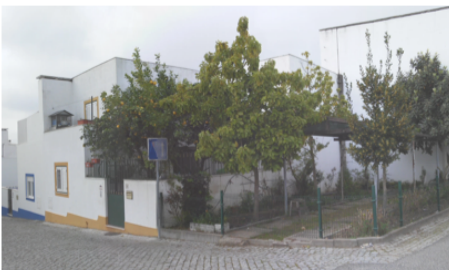
Figura 49. Bairro da Malagueira: privatização de área pública para guarda de veículo.
