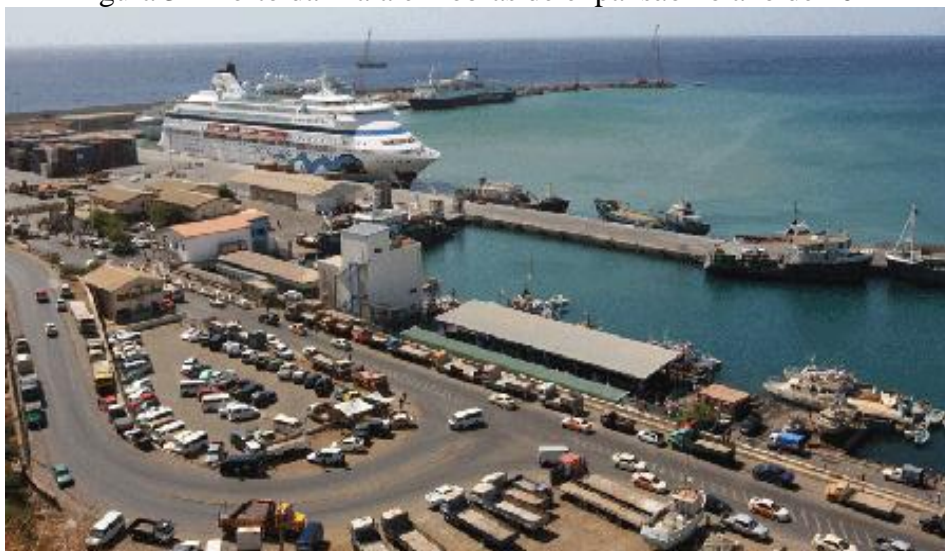
Figura 3 – Porto da Praia em obras de expansão no ano de 2012
