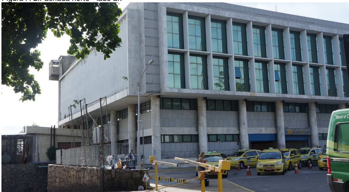
Figura A-2: Fachada norte - lado ar.
