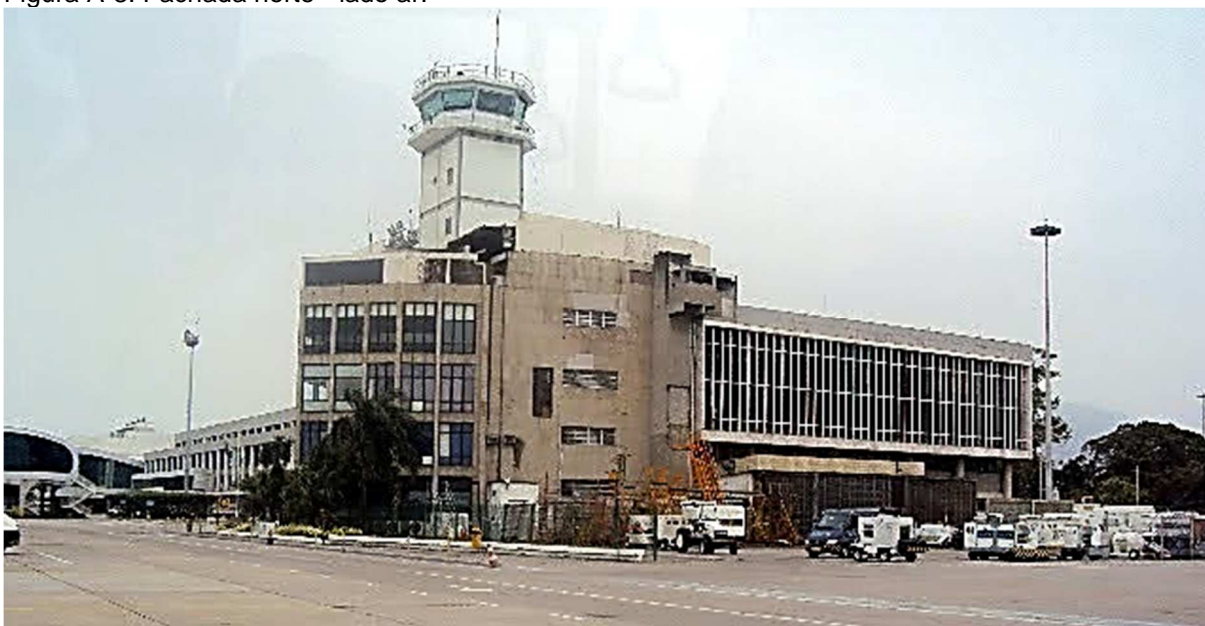
Figura A-3: Fachada norte - lado ar.
