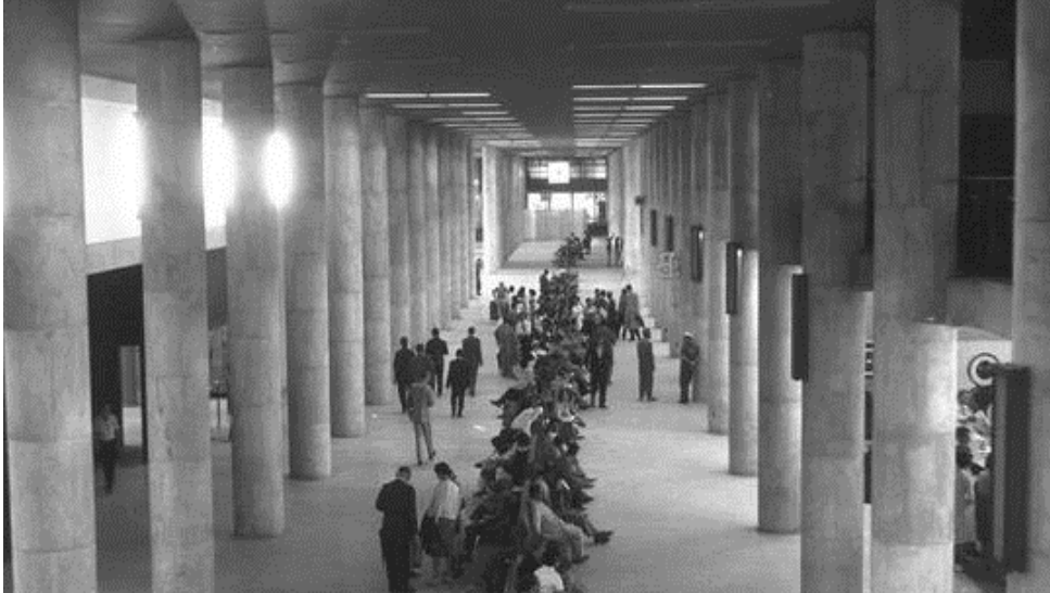
Figura 33: Circulação saguão do atual saguão de desembarque.
