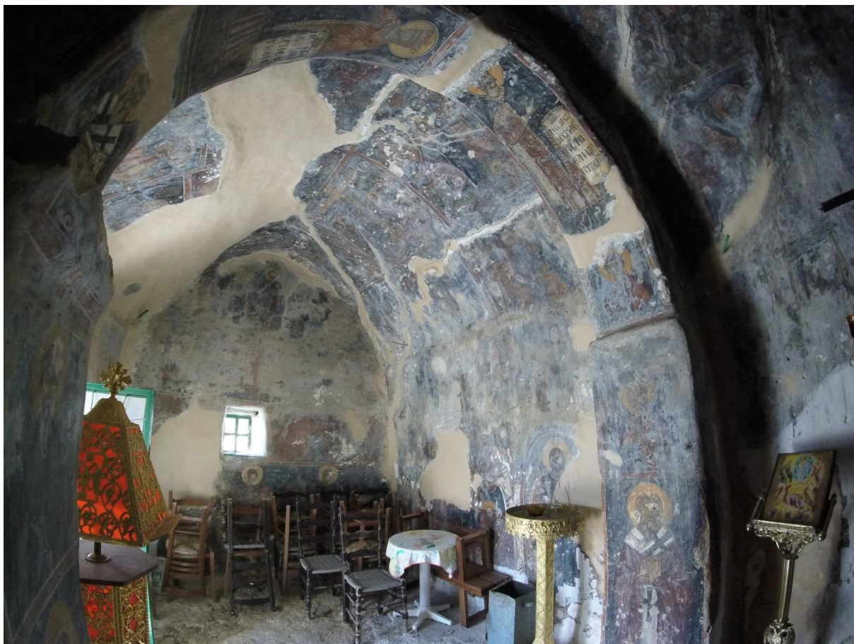
Figura 7 – Paredes ocidental e norte da capela Fonte: acervo pessoal
