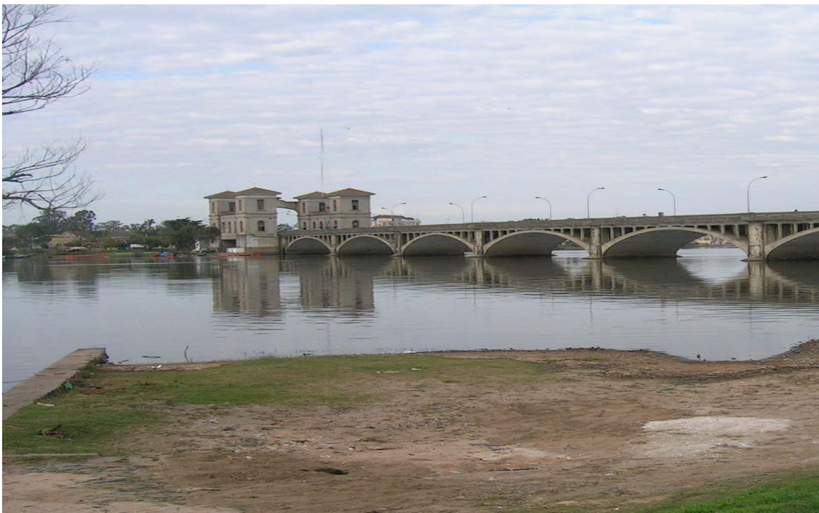
Ponte Internacional Barão de Mauá – Jaguarão/Rio Branco 14.07.06
