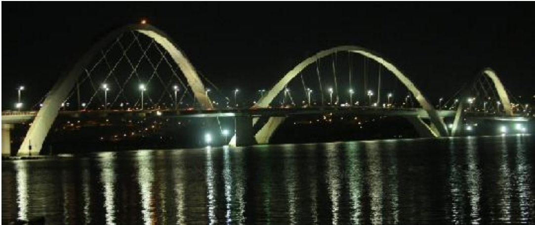
Figura 2.28 Ponte JK Fonte: Sérgio Francês, 2016.
