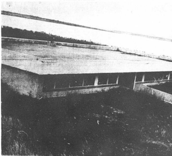
O vestiário, ao invés de circundado por gramas, partilha com o matinho a sua existência de concreto
