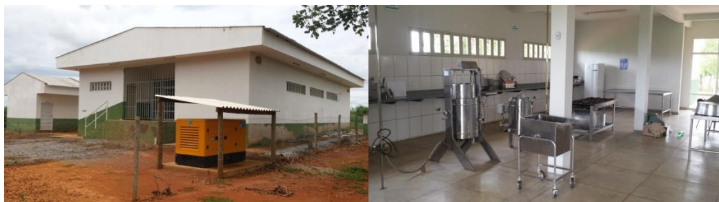
Agroindústria construída na Escola Agrícola de Unai-MG
