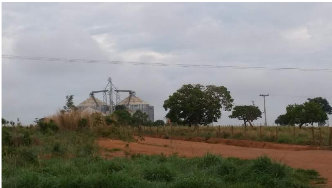
Foto 9.8 – Silos de armazenagem em Padre Bernardo - GO
