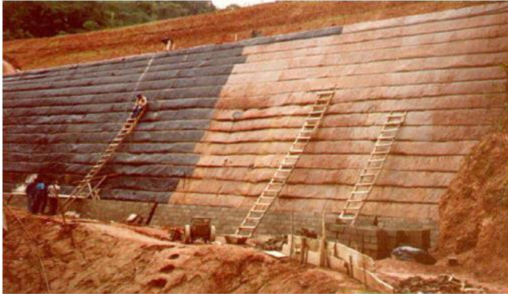
Figura 2.13 Muro reforçado na rodovia SP-125 (Carvalho et al. , 1986)
