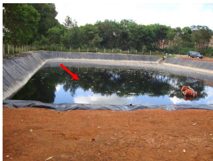
Figura 4.6: Lagoa de acumulação de chorume localizada no aterro controlado Jockey Club de Brasília, DF.
