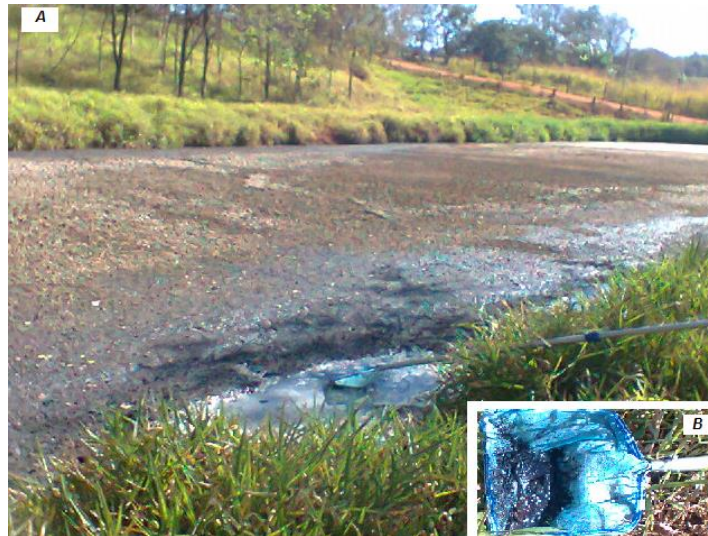
Figura 4.5: Lagoa anaeróbia tratando efluente de abatedouro de suínos. A) vista da lagoa anaeróbia. B) Aspecto do lodo coletado no fundo da lagoa anaeróbia.
