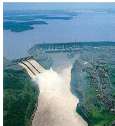
Reservatórios de água
