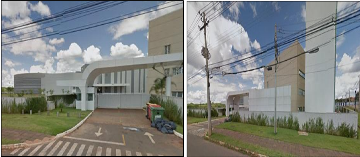
Fotos 6.1 e 6.2 Entrada do Complexo do Datacenter
