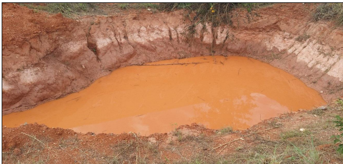
Foto 6.8 Área de contenção da rede de drenagem do PTCD
