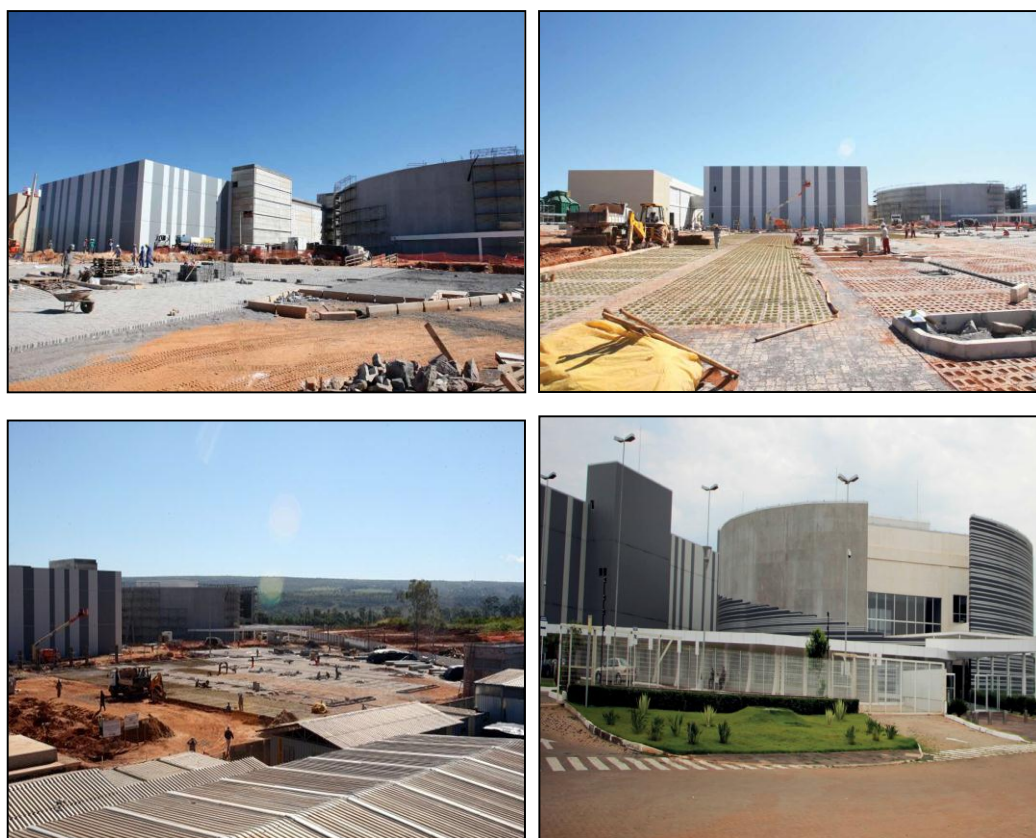
Figura 6.11 Fases da construção do Datacenter
