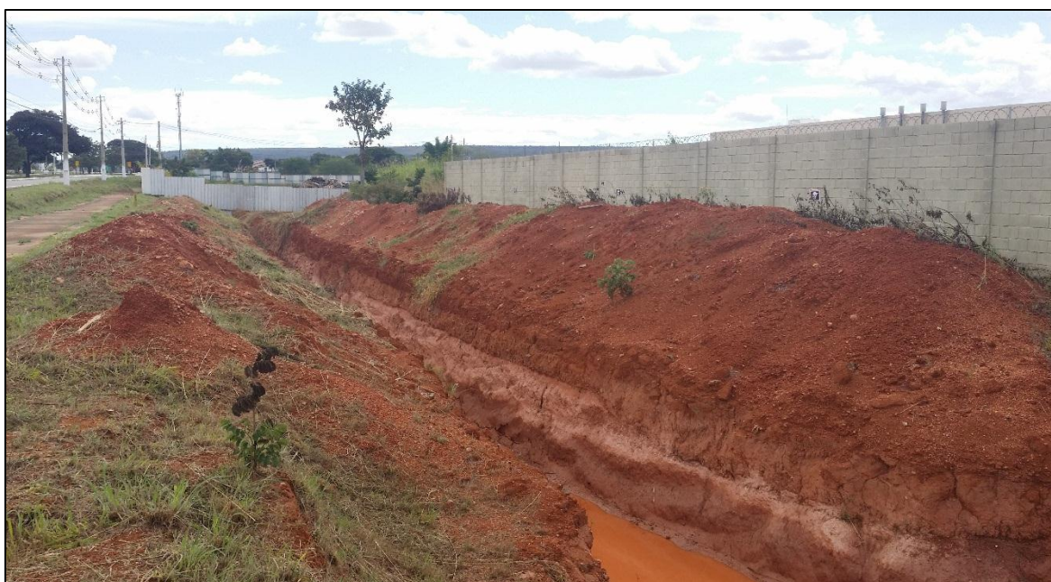
Foto 6.7 Saída da rede de drenagem do PTC D às margens da via de acesso secundário
