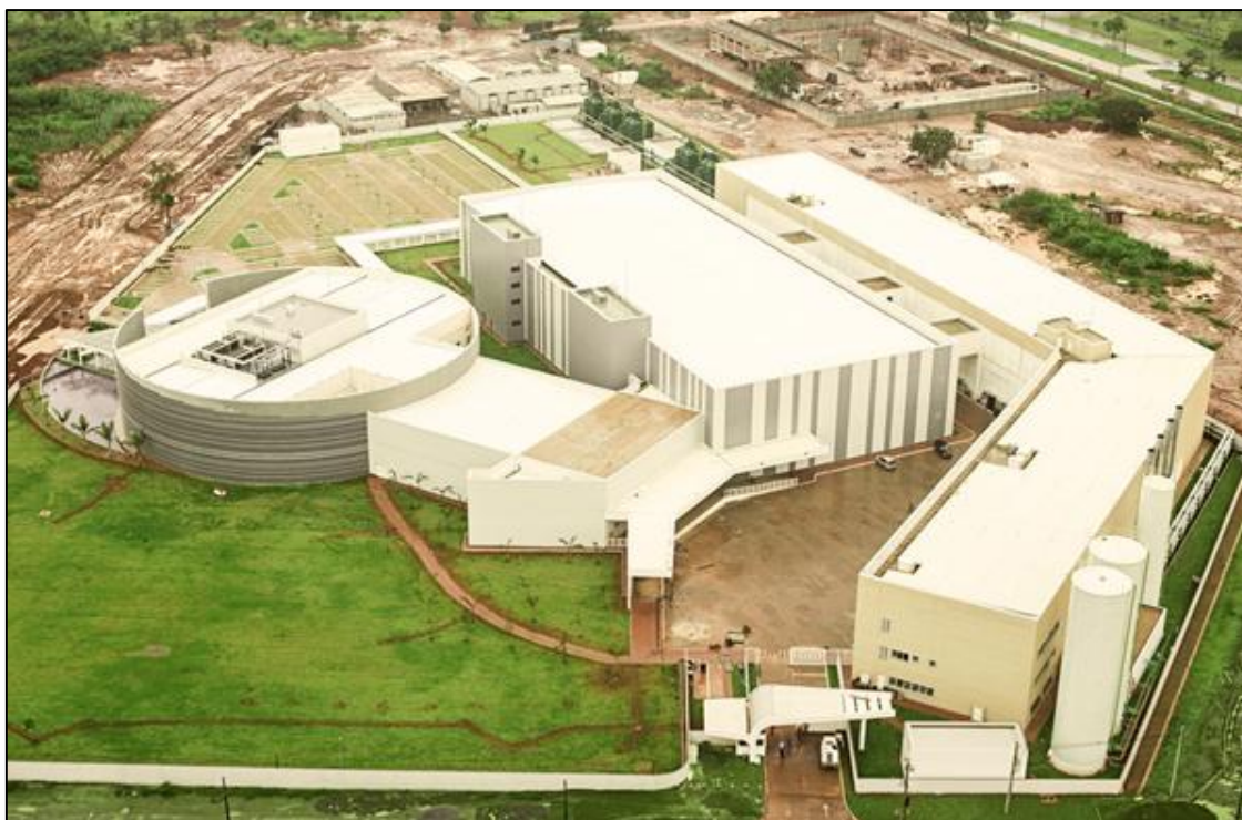
Figura 6.12 Complexo do Datacenter no PTCD
