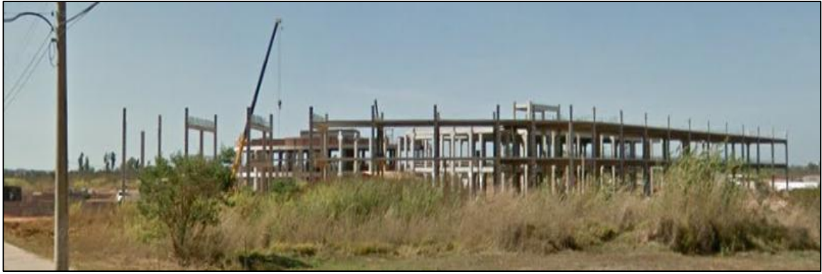
Figura 6.7 Início das obras no Parque Tecnológico Capital Digital
