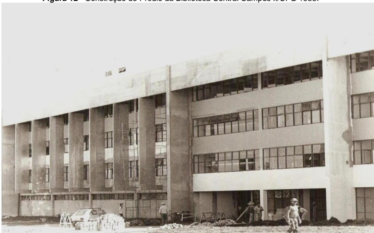
Figura 12 - Construção do Prédio da Biblioteca Central Campus II/UFG 1988.
