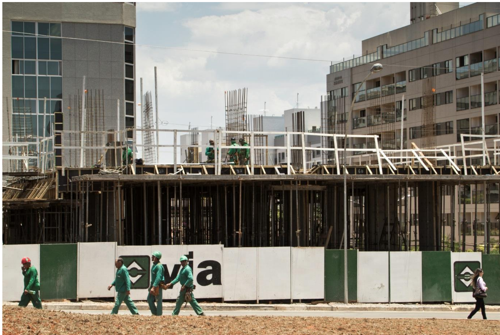
Foto 8 – As obras começam. A partir de agora horas são horas de trabalho
