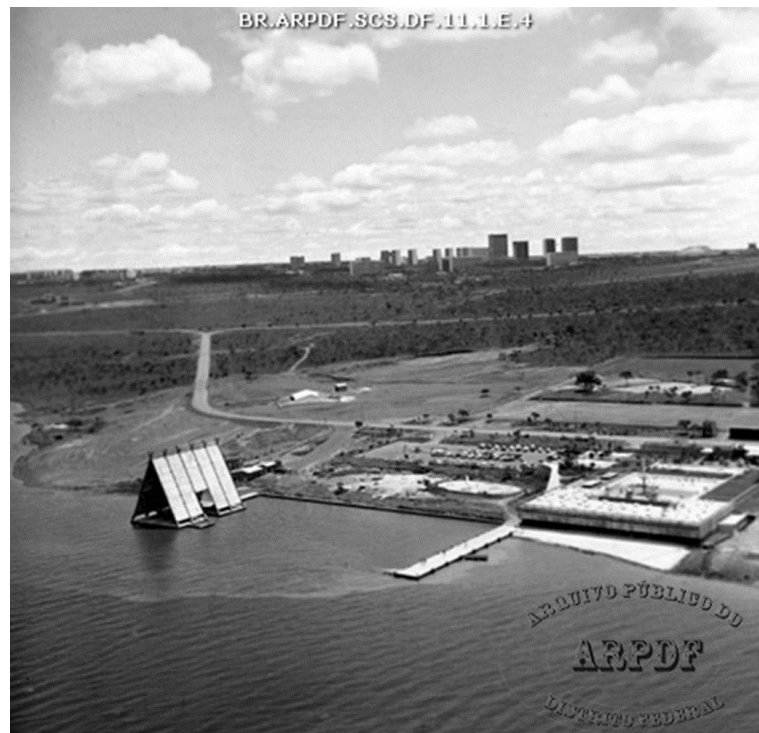
Figura 2.5- Vista aérea do Clube Cota Mil de Brasília, 23 de março de 1964. Fonte: Arquivo Público do Distrito Federal.
