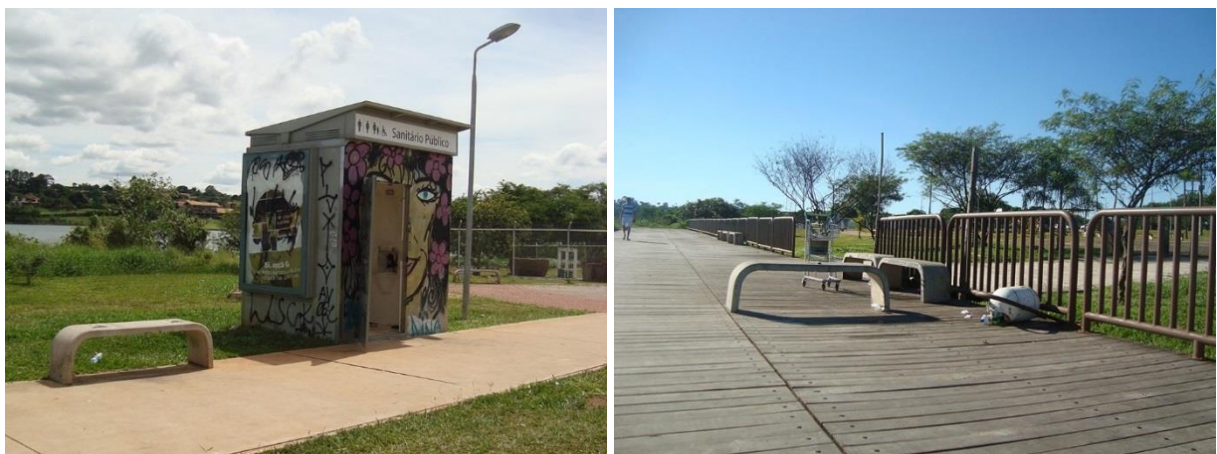
Figura 3.35- O único banheiro público e algumas lixeiras e bancos estão depredados. Crédito: Marcelo Lembi.
