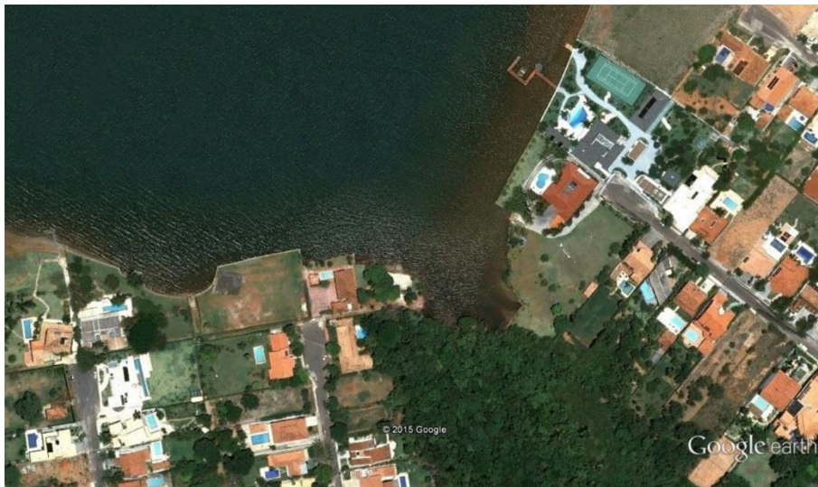
Figura 2.3- Invasões de área pública pelas habitações individuais no SHIS entre a QL 22, Conjunto 9 e a QL 24, Conjunto 1 (Lago Sul). Em alguns casos, não somente as áreas de lazer (piscina, churrasqueira, quadra de esportes, atracadouro, etc.), mas também a própria moradia foi construída em área pública. Fonte: Google Earth.
