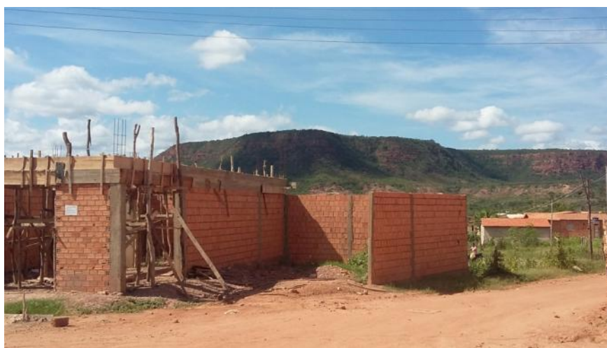
Figura 35: Obra de construção civil presente em Bom Jesus
