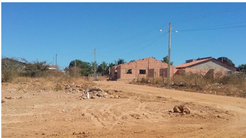
Figura 50: Ruas sem asfaltamento em Bom Jesus-PI
