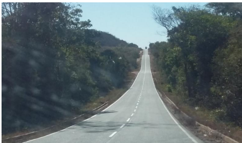
Figura 51: Trecho da BR-135-PI
