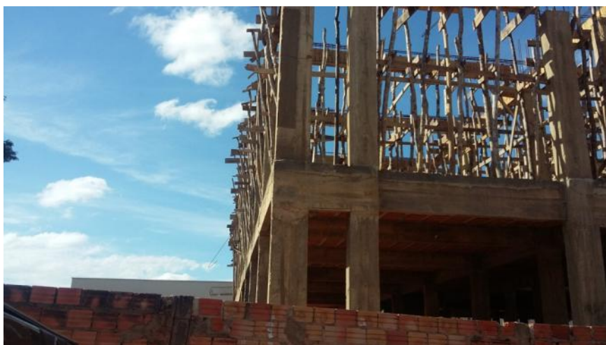
Figura 34: Construção de Shopping Center em Bom Jesus (PI)
