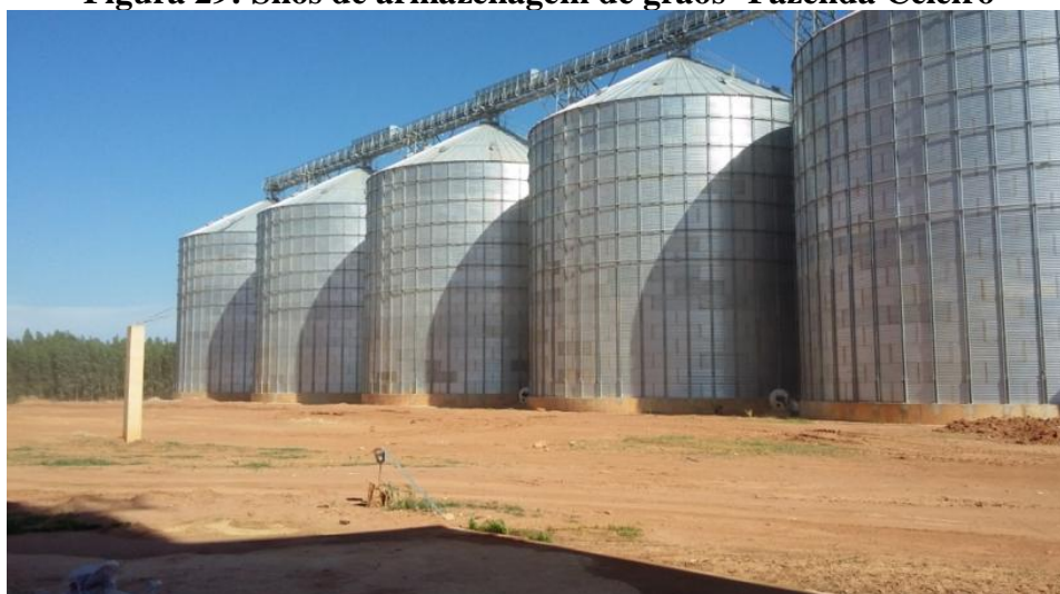
Figura 29: Silos de armazenagem de grãos- Fazenda Celeiro
