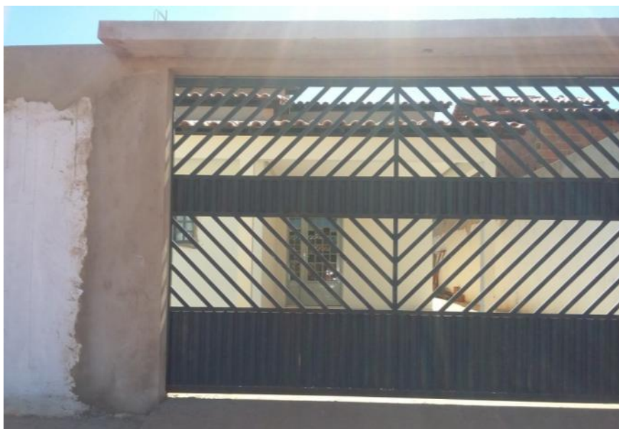
Figura 49: Residência no Condomínio Consórcio das Águas II
