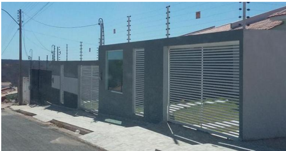
Figura 48: Casas com cercas elétricas no Condomínio Consórcio das Águas
