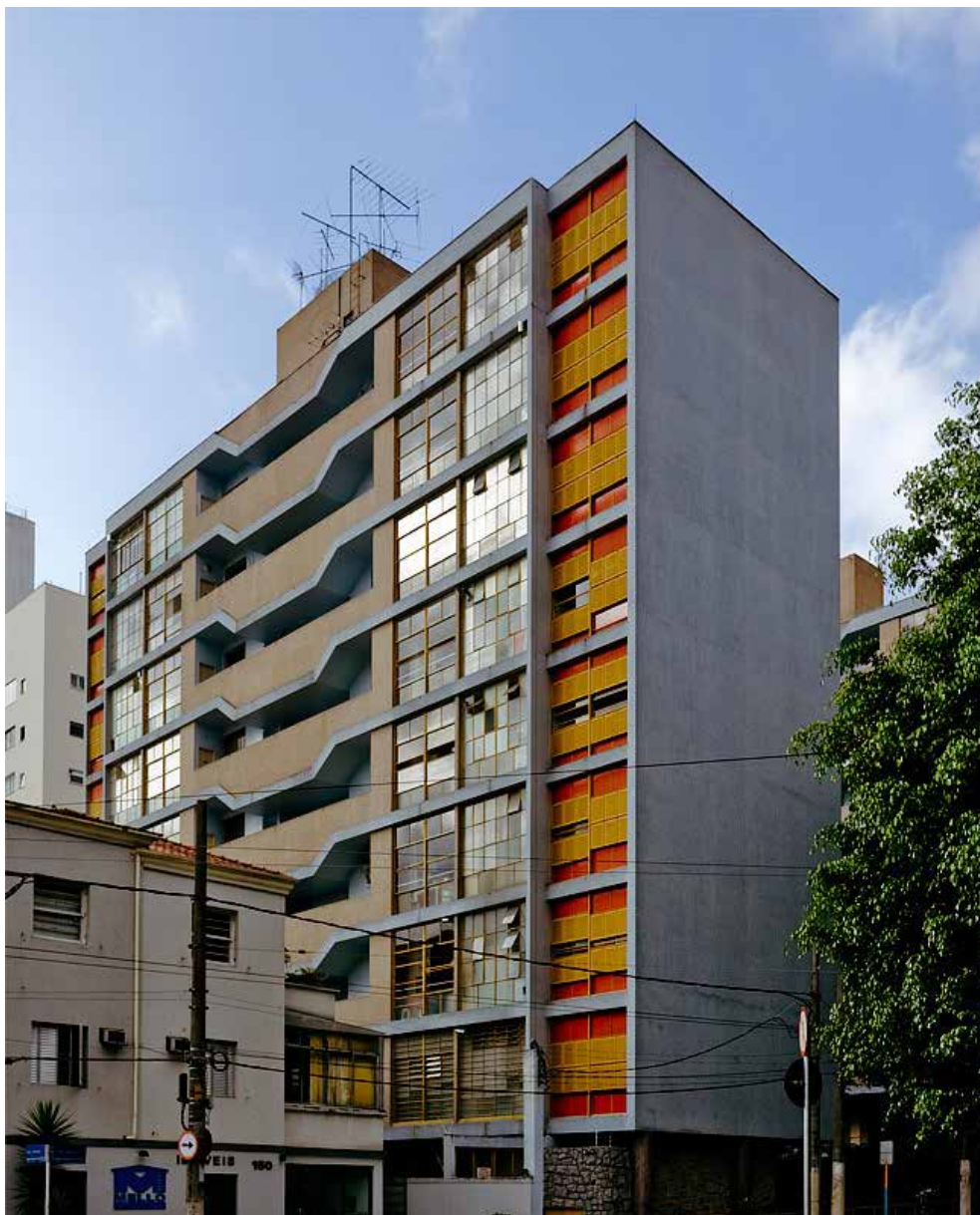
F. 7 - Edifício Louveira - Vista do bloco B (fonte: Acervo Pedro Kok)
