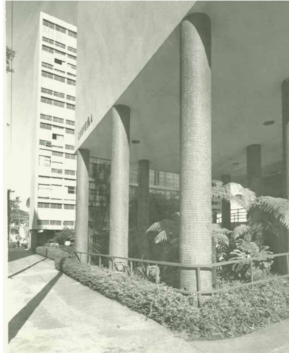
F. 4 - Edifício Louveira - Vista entrada do bloco A (fonte: Acervo FAUUSP)
