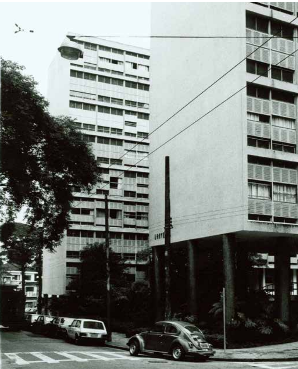
F. 3 - Edifício Louveira - Vista entrada do bloco A (fonte: Acervo FAUUSP)
