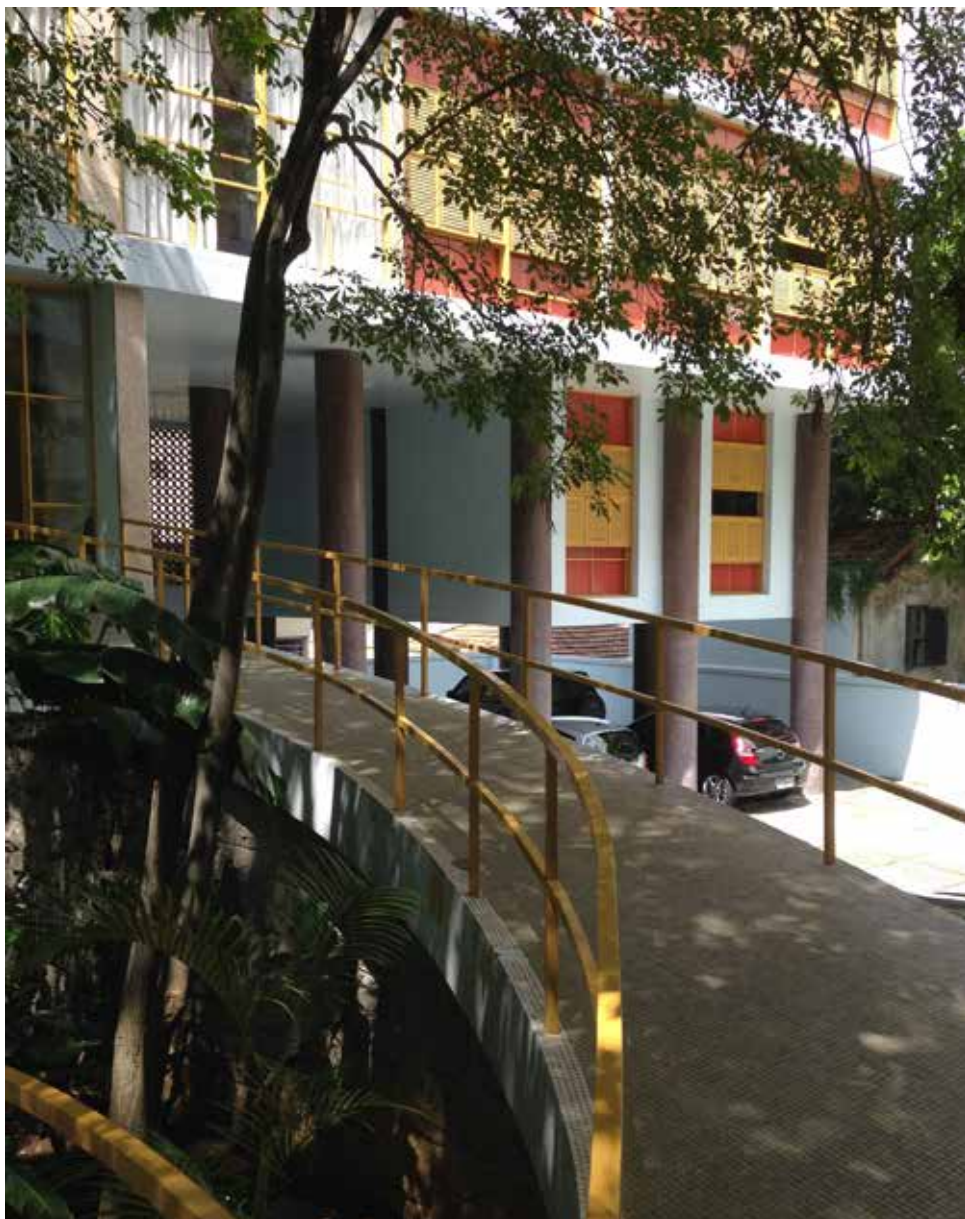
F. 29 - Rampa sentido bloco B (fonte: Thiago P. Turchi)
