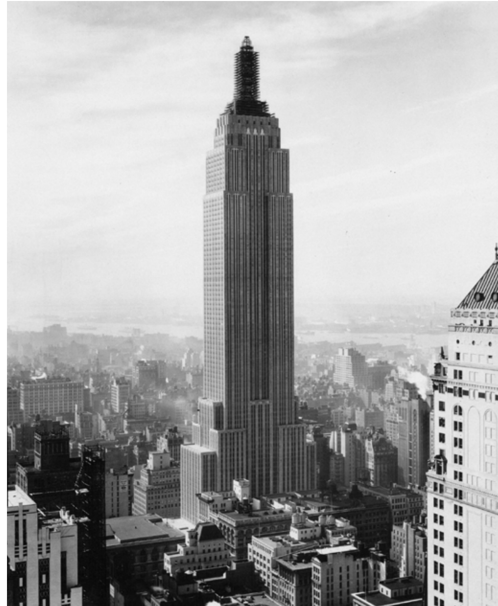
F. 8 - Edifício Empire State, em construção NY 1930 (fonte: http://njbiblio.com/tag/new-york-city/ )
