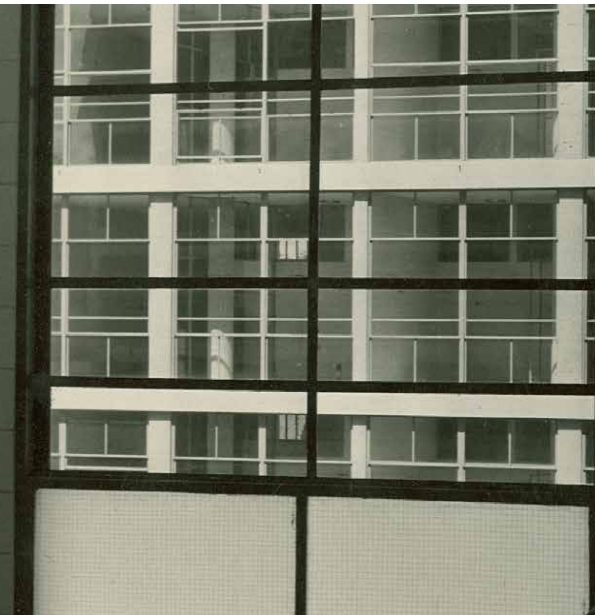
F. 9 - Edifício Louveira - Cozinha do Bloco B Vista do bloco A (fonte: Acervo FAUUSP)
