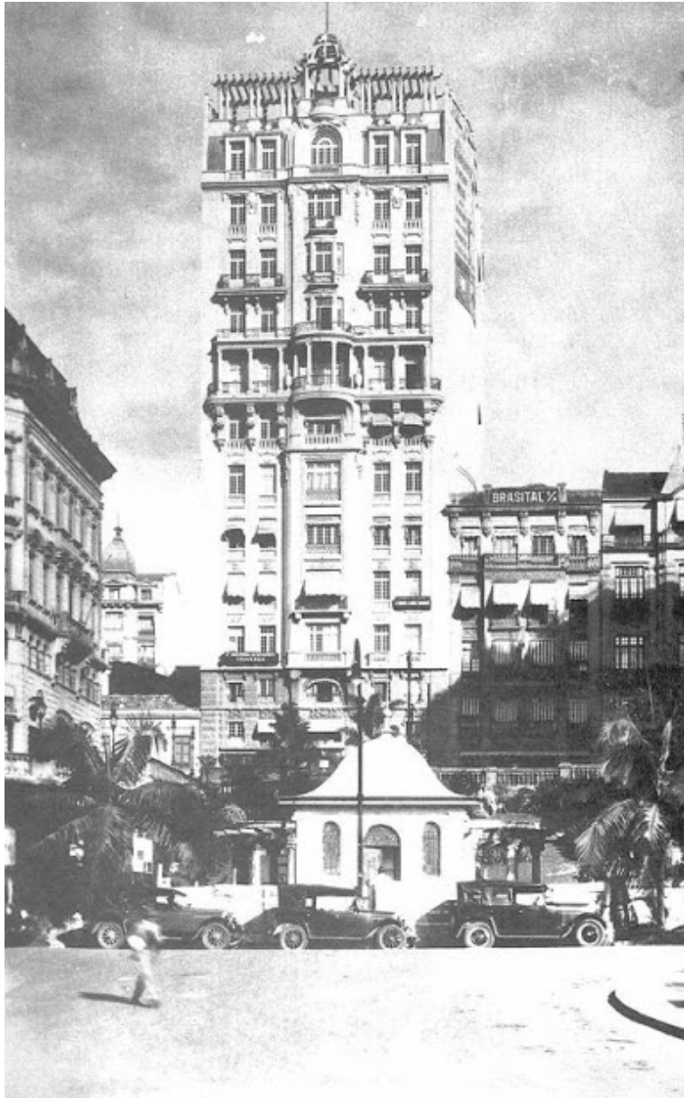
F. 13 - Sampaio Moreira, São Paulo 1937 (fonte: http://www.saopauloskyline.com/2012/10/edificio-sampaio-moreira.html )
