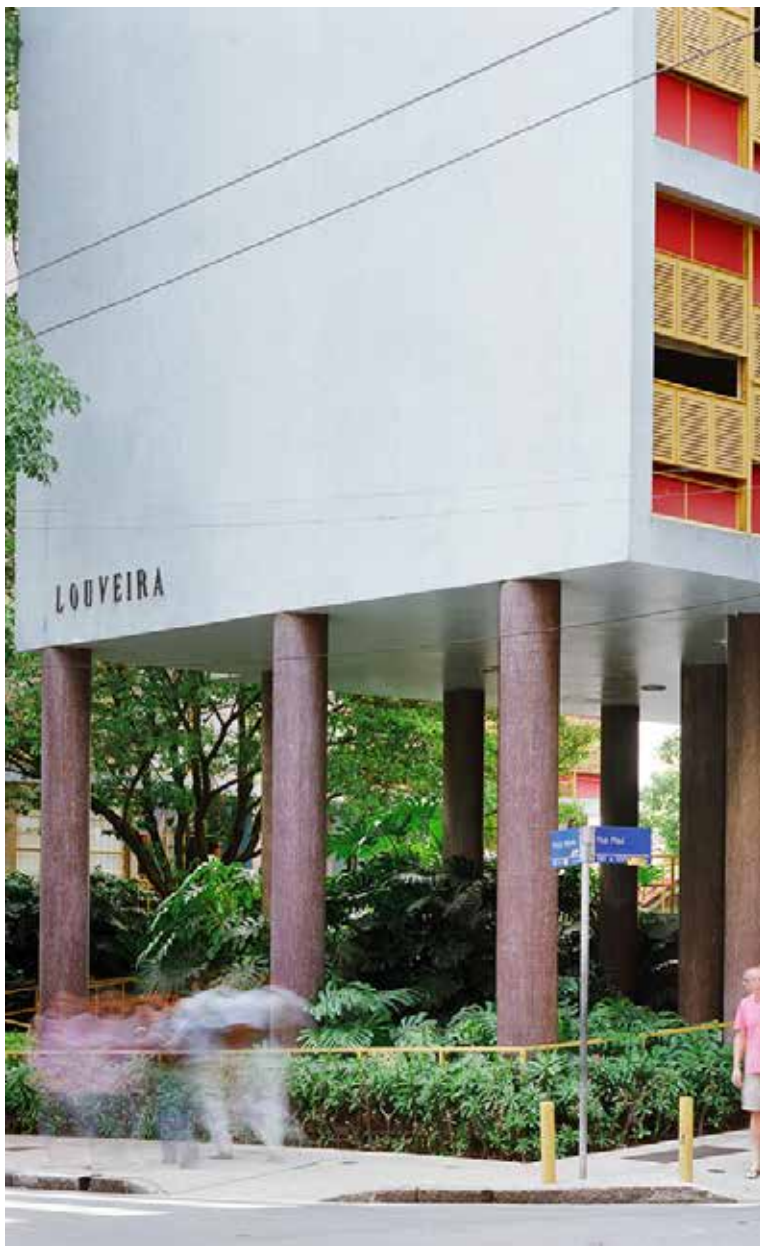
F. 3 - Edifício Louveira, bloco A (fonte: Pedro Kok)
