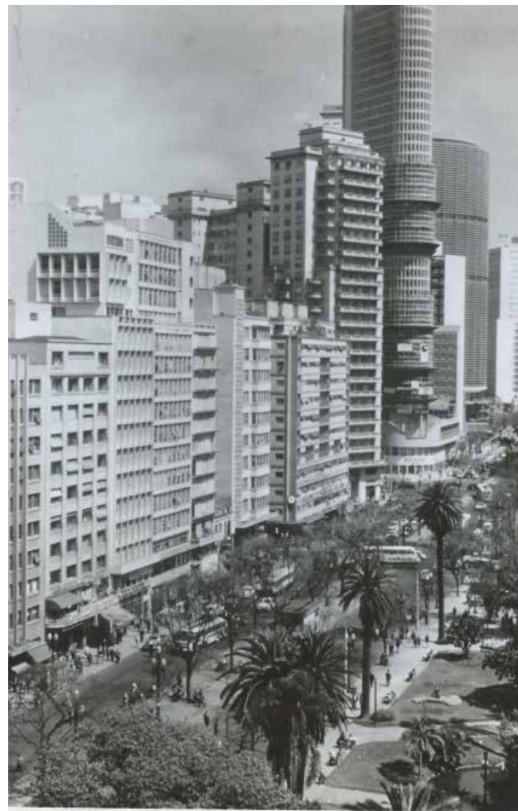
F. 19 - Edifício Esther de Álvaro Vital Brazil e Adhemar Marinho 1935-38, na Avenida Ipiranga - São Paulo (Fonte: https://quandoacidade.wordpress.com/page/2/ )
