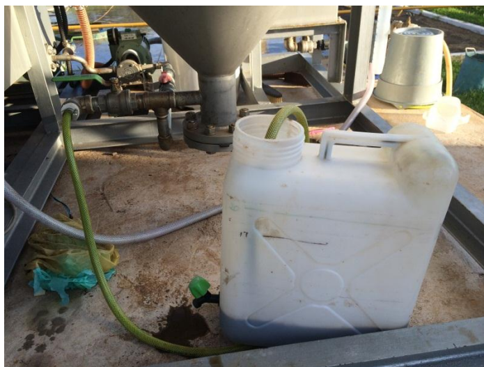
Figura 4. 14: Detalhe do descarte de lodo de fundo do tanque de sedimentação
