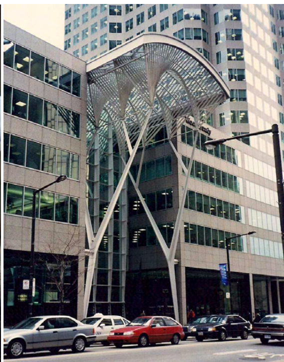
Figura 110 Acesso a complexo multifuncional e metrô, Toronto Fonte: Arquivo pessoal (1998)
