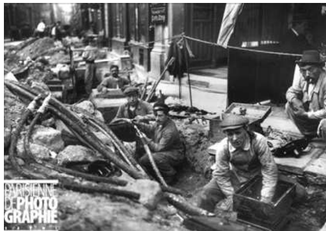
Figura 18 Rede elétrica subterrânea - Paris (1910) Fonte: Parisenimages (2008)
