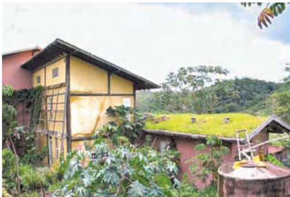
Figura 5 Telhados Verdes Fonte: Correio Braziliense (2009)
