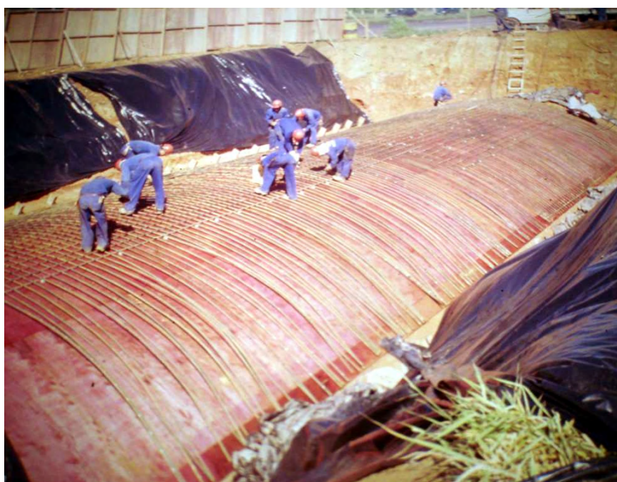
Figura 70 – Túnel Onoyama, em Taguatinga, Distrito Federal Fonte: Arquivo Pessoal (2004)
